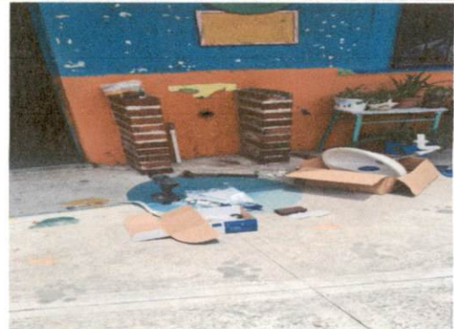
Foto 2: CAMBIO DE LAVAMANOS CON ACCESORIOS
