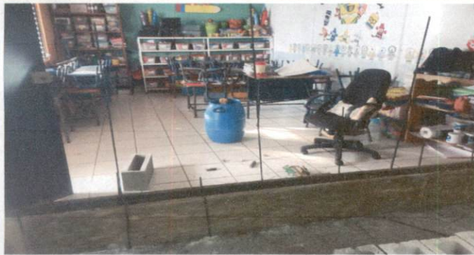
Foto 1: FABRICACIÓN DE MURO EN AULA 1
