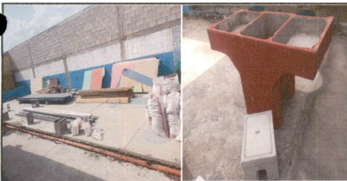
Foto 5: INSTALACIÓN Y MOVIMIENTO DE NUEVA PILA
