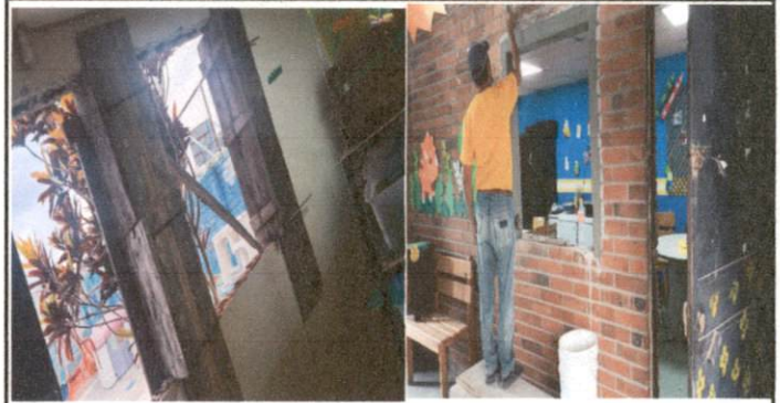
Foto 4: APERTURA DE VENTANAS EN 2 AULAS
