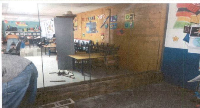
Foto 3: FABRICACIÓN DE MURO EN AULA 2 Y 3
