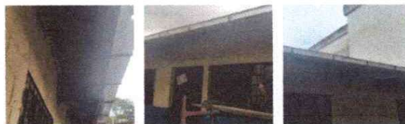
Foto 6: Cambio canales y bajadas
