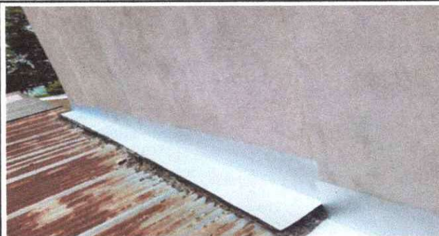
Foto 2: Flashing, bota aguas instalado
