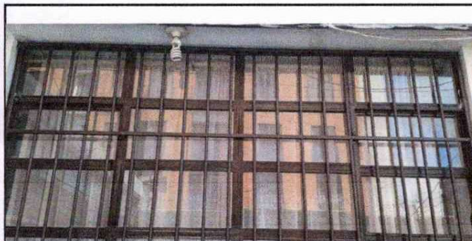
Foto 3: Instalación de balcón de la cocina de la escuela.
