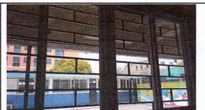
Foto 6: Instalación de ventanas de PVC y vidrio.
