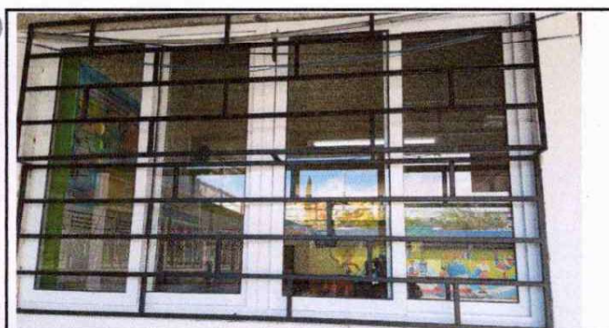
Foto 5: Instalación de ventanas de PVC y vidrio.
