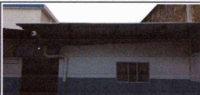
Foto 2: Cambio de canal de bajada de agua de la guardiania.
