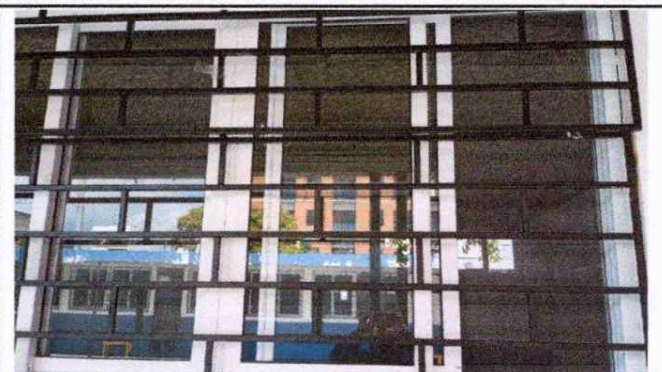
Foto 8: Resanado de Balcones
