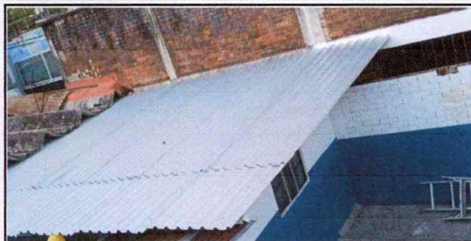
Foto 1: Cambio de cubierta de lamina de la guardiania.
