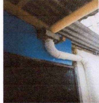
Foto 2: Cambio de canal de bajada de agua de la guardiania.
