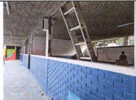
Foto 6: Extracción de balcones, ventanal de metal y vidrio.
