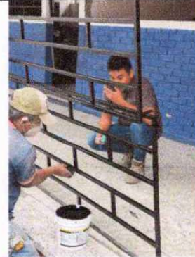
Foto 8: Resanado de Balcones
