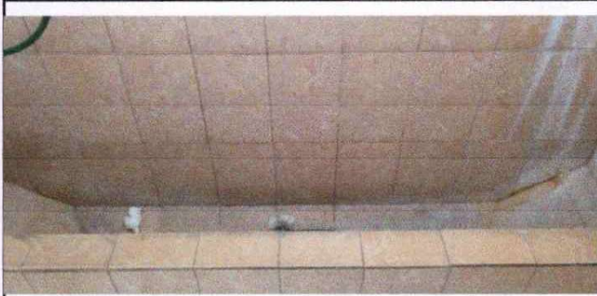
Foto 7: Reparación del area del migitorio obstruido.
