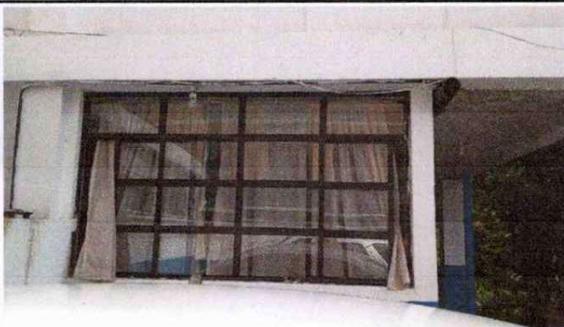
Foto 3: Instalación de balcón de la cocina de la escuela.
