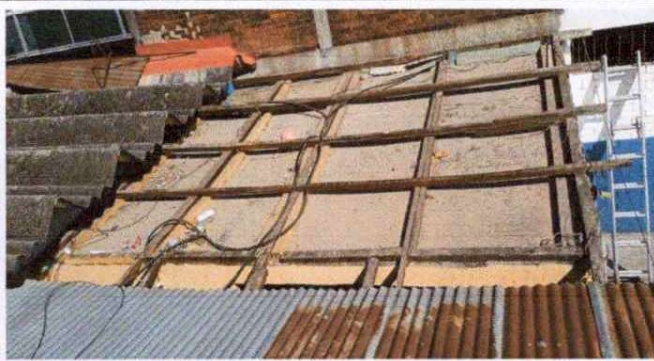
Foto 1: Cambio de cubierta de lamina de la guardiania.
