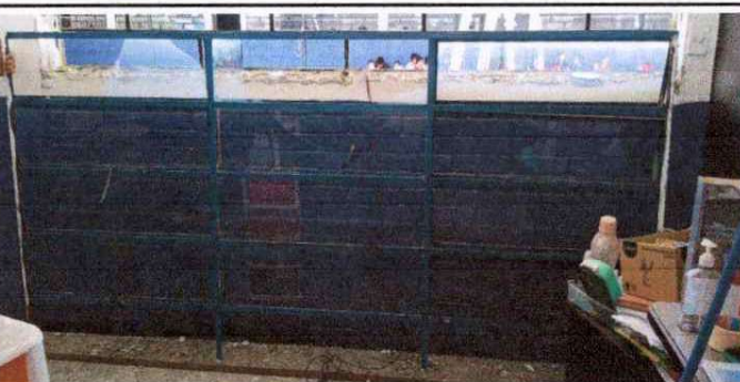
Foto 5: Extracción de balcones, ventanal de metal y vidrio.
