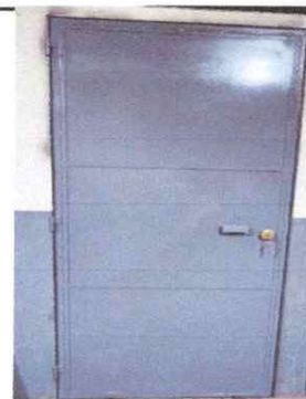
Foto 4: Sustitución de puertas de madera por puertas de metal de 1mx2m con chapa marca Yale
