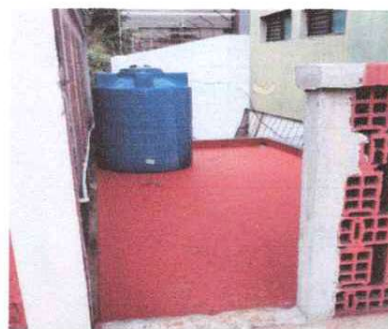
Foto 6: Impermeabilización de loza en área de los sanitarios de los niños
