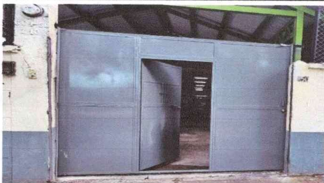
Foto 3: Sustitución de portón de metal de dos hojas por portón corredizo 2.40x3
