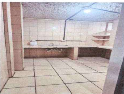
Foto 5: Sustitución de sistema eléctrico en cocina
