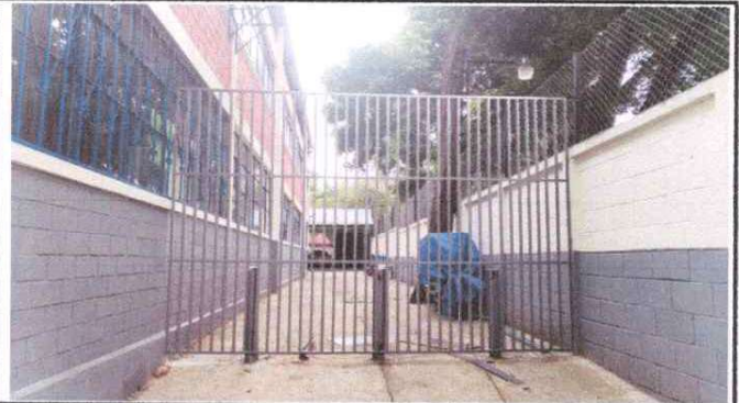
Foto 2: Instalación de reja de metal de 2.50m x 3.80m que divide el parqueo y la cancha deportiva
