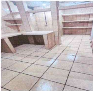
Foto 1: Ampliación de mesas de cocina con block y fundición de concreto. Instalación de azulejo blanco de 20x30cm en paredes de cocina. Instalación de piso cerámico beige de 30x30cm en cocina
