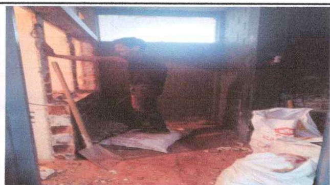
Foto 3: Ampliación de mesas de cocina con block y fundición de concreto .
