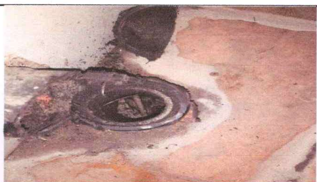
Foto 5: Remozamiento de drenaje en areas de sanitarios de niños y sanitario de maestros de primer nivel con maquina de Sondeo y extractor de desechos
