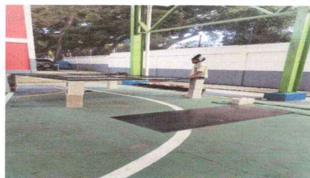
Foto 2: Instalación de reja de metal de 2.50m x 3.80m que divide el parqueo y la cancha deportiva
