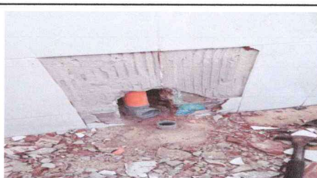
Foto 4: Remozamiento de drenaje en lavamanos y sanitarios en area de niñas segundo nivel.
