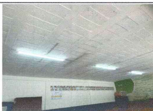
Foto 6: FUNCIONAMIENTO DE ILUMINACION POR CAMBIO DE CNDELAS EN PRIMER Y SEGUNDO NIVEL
