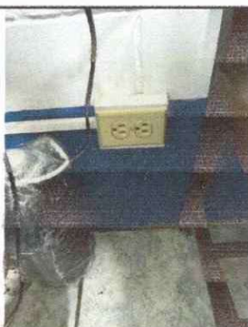
Foto 5: PROTECCION DE CABLEADO EN EL CAMBIO DE TOMACORRIENTES EN PRIMER Y SEGUNDO NIVEL
