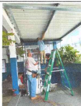
Foto 4: INSTALACION DE CABLEADO ELECTRICO EN LA ENTRADA PEATONAL
