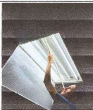
Foto 3: FUNCIONAMIENTO DE CANDELAS DE PRIMER Y SEGUNDO NIVEL
