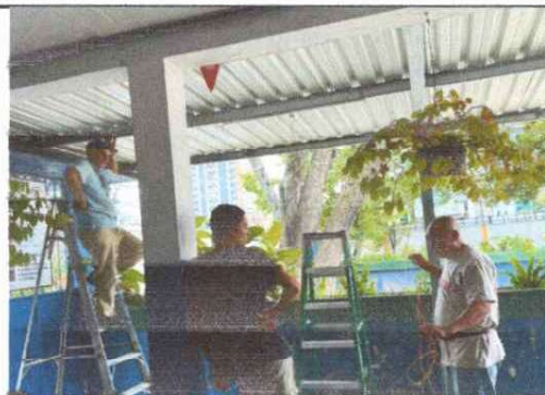
Foto 4: Colocacion de cableado electrico en corredor del paso peatonal
