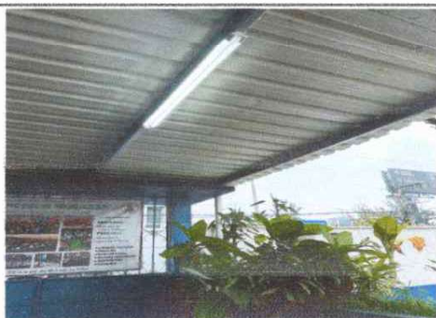
Foto 5: Instalacion de candelas en el corredor primer nivel (entrada)
