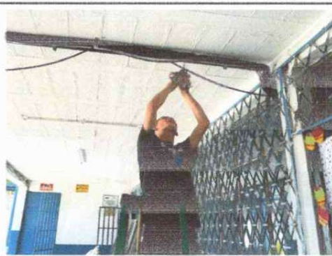
Foto 2: proteccion de cableado electrico en corredores del primer y segundo nivel
