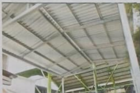
Foto 7: Estructura de metal y cubierta de lamina colocados
