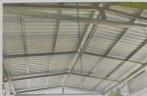
Foto 8: Estructura de metal y cubierta de lamina colocados
