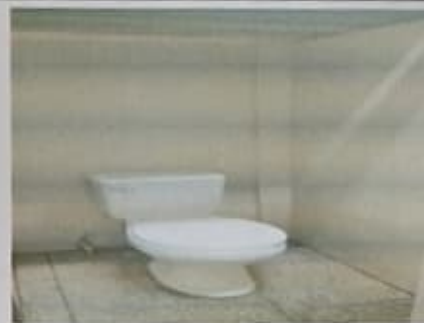
Foto 12: Instalación de Sanitarios en Baños y piso ceramico
