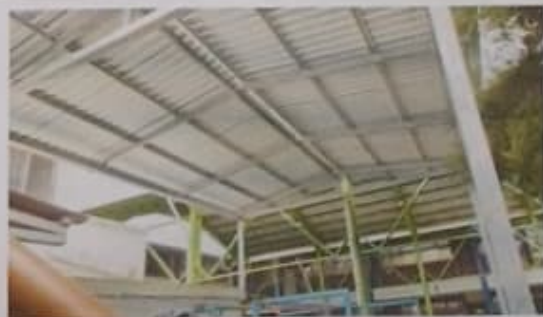
Foto 5: Se observa la estructura metalica y la cubierta de lamina colocada
