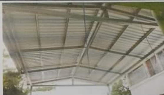
Foto 4: Se observa la estructura metalica y la cubierta de lamina colocada
