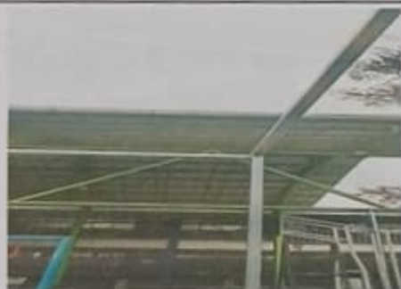
Foto 3: Instalando Estructura Metalica
