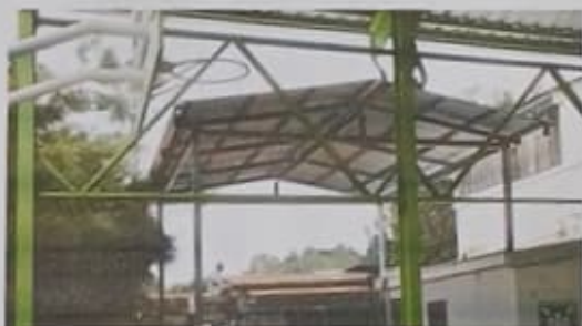
Foto 9: Estructura de metal y cubierta de lamina colocados
