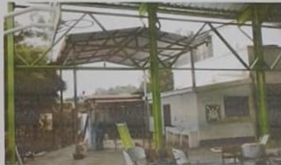
Foto 6: Se observa la estructura metalica y la cubierta de lamina colocada
