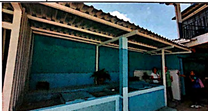
Foto 8: Suministro e instalación de estructura de metal portante mas instalación de lamina troquelada aluzinc calibre 26 en el módulo de pilas, finalizado al 100%
