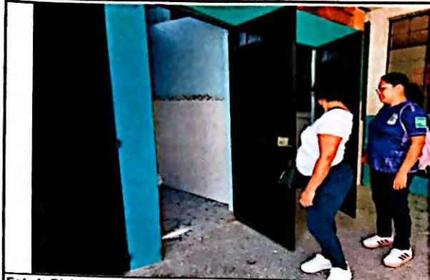
Foto 1: Divisiones en módulos de sanitarios con tabique 10 cm x 20 cm x 40 cm. Finalizada al 100%
