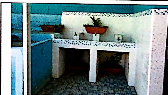
Foto 6: Instalación y suministro de lavamanos fundido mas instalación de azulejo. Finalizado al 100%
