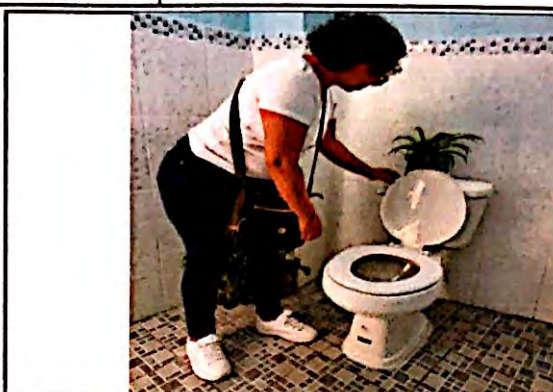
Foto 2: Instalación y suministro de tres inodoros mas accesorios finalizada al 100%
