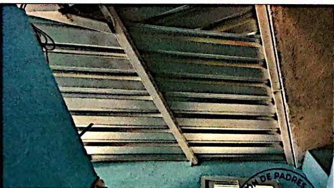
Foto 5: Instalación y suministro de estructura de metal portante mas lamina troquelada aluzinc calibre 26 en el módulo de baños, finalizado al 100%
