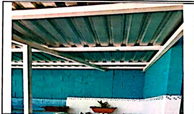
Foto 7: Instalación y suministro de estructura de meral portante mas lamina troquelada aluzinc calibre 26. en el módulo de lavamanos, finalizada al 100%
