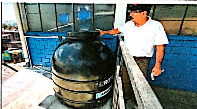
Foto 9: Suministro e instalación de sistema de deposito de agua de 1100 lts para modulo de de servicios sanitarios finalizado al 100%
