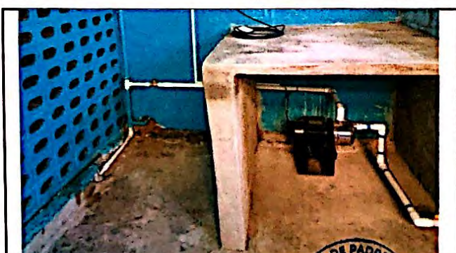
Foto 11: Fabricación de caceta para bomba, finalizada al 100%
