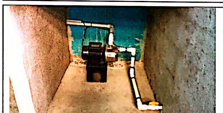
Foto 10: Suministro e instalación de sistema de bombeo mas accesorios como mejora para el sistema de agua potable del establecimiento, finalizado al 100%
