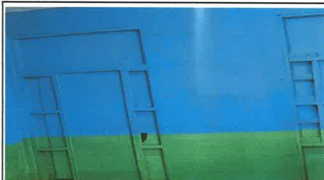
Foto 6: AMPLIACION DE MURO DE TABLA YESO PARA AULA Y DIRECCION, DE PREPRIMARIA.
