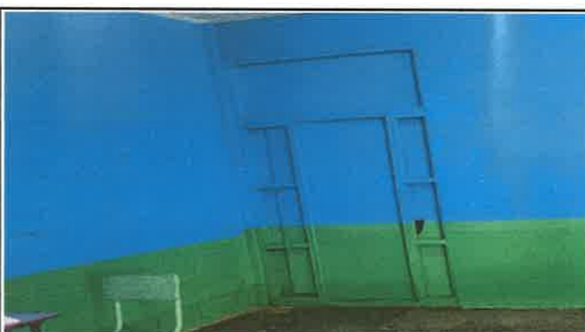
Foto 11: AMPLIACION DE MURO CON REFUERZO DE ACERO PARA BAÑO.
