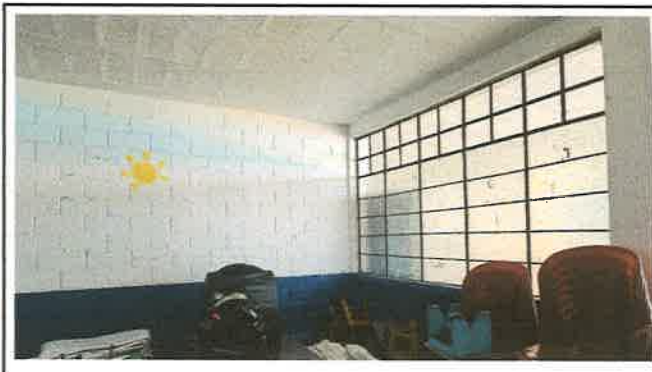
Foto 10: COLOCACION Y SUMINISTRO DE BLOCK PARA LEVANTADO DE MURO DE BLOCK CON REFUERZO DE ACERO.
