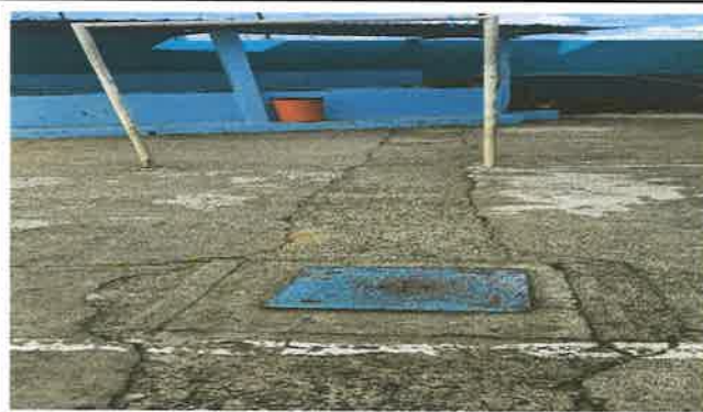
Foto 4: REMOZAMIENTO DE CAJAS DE REGISTRO PARA EVITAR LOS MALOS OLORES DE LAS AGUAS NEGRAS.
