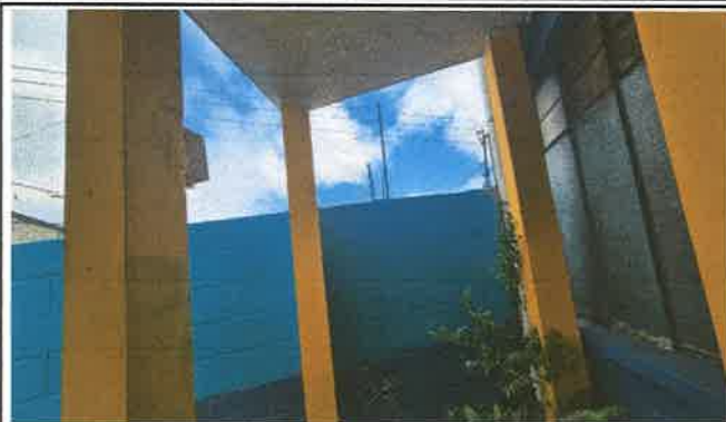
Foto 7: MEJORAMIENTO DE MURO AMPLIANDO CON REFUERZO ESTRUCTURAL.
