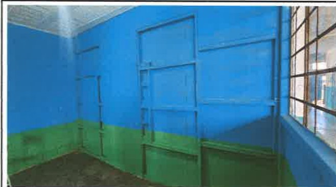
Foto 5: REMOZAMIENTO DE MURO CON TABLA YESO.
