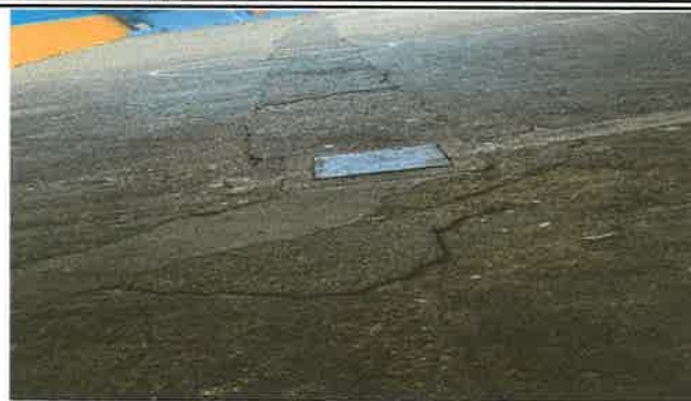
Foto 2: SUMINISTRO E INSTALACION DE TUBERIA PVC LINEA PRINCIPAL DRENAJES
