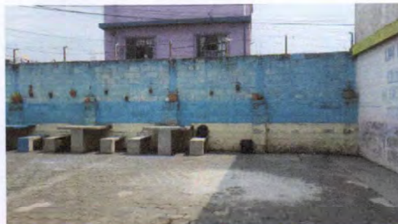
Foto 2: PINTURA ZOCALO Y PERED SUPERIOR LADO INTERNO, LEVANTADO DE BLOCK DE 3 HILADAS SOBRE MURO DE PATIO Y COLOCACIÓN DE ALAMBRE ESPIGADO
