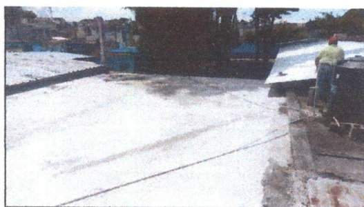
Foto 3: Impermeabilización de losa en Biblioteca
