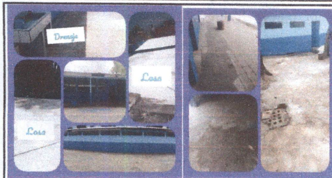
Foto1: Trabajos realizados (drenajes, pintura en muros y reparación de losa)
