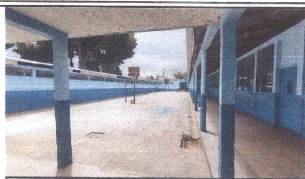
Foto 2: Pntura en muros
