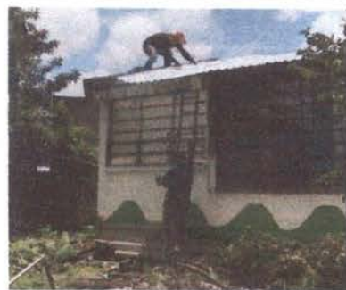
Foto 6: Instalación de lámina de aluzinc
