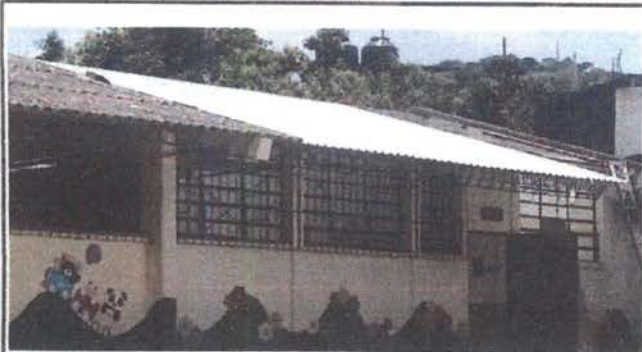
Foto1: Instalación de lámina de aluzinc
