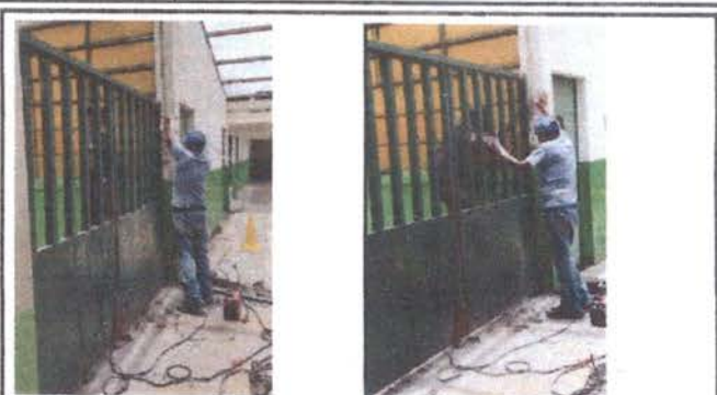
Foto 2: Reparación de portones
