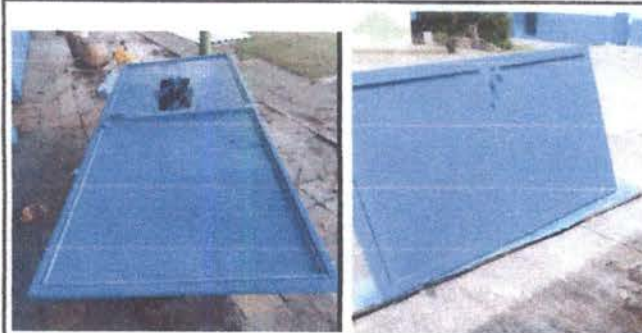
Foto 5: Reparación de puertas
