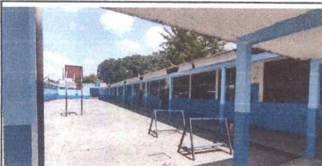
Foto 3: Pintura en muros
