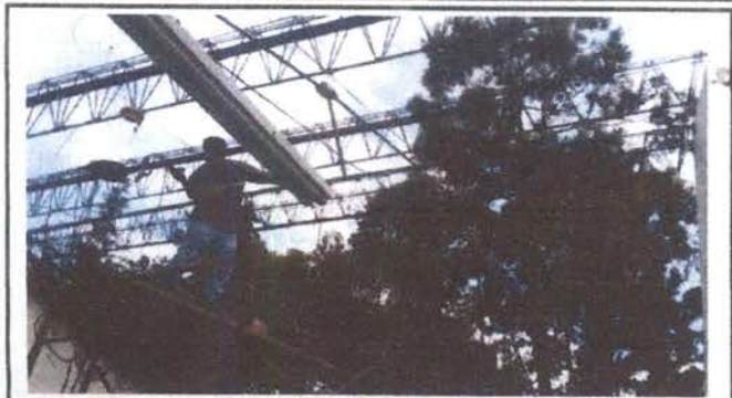
Foto1: Pintura e instalación de estructura metálica en Aula Inclusiva
