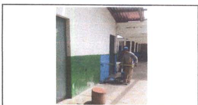
Foto 5: Pintura de muros
