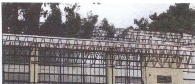
Foto1: Estructura metálica de Aula Inclusiva
