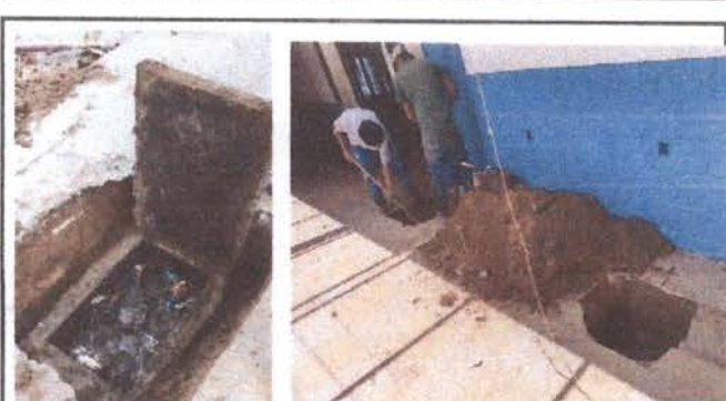
Foto 4: Reparación de cajas
