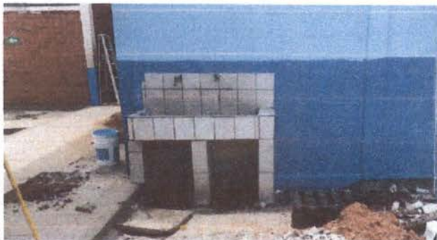
Foto 4: Revisión de cajas de drenaje
