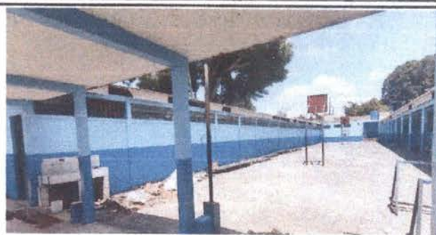
Foto 2: Pintura en muros
