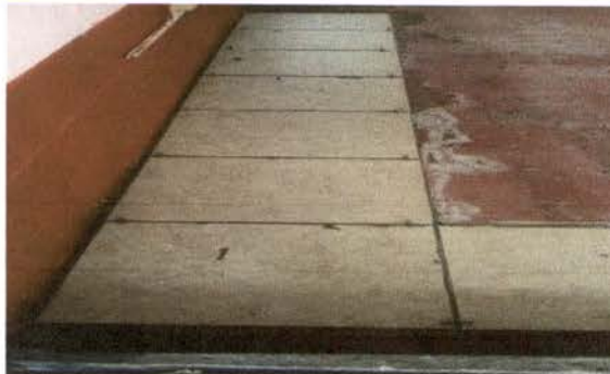
Instalación de piso cerámico en laboratorio de práctica supervisada en Secretariado.
