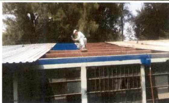
Remozamiento de Costaneras
