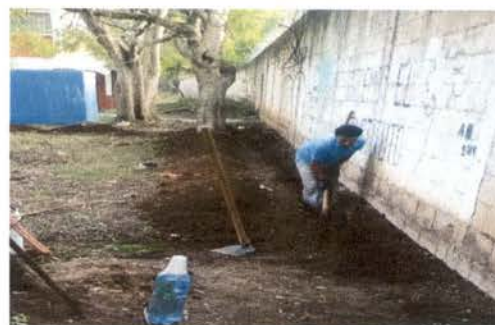
Instalación de 131 metros lineales de tubo PVC de ¾"
