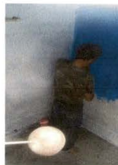
Limpieza y pintura de cisterna
