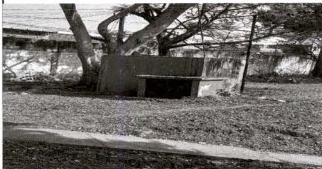
Limpieza y pintura de cisterna
