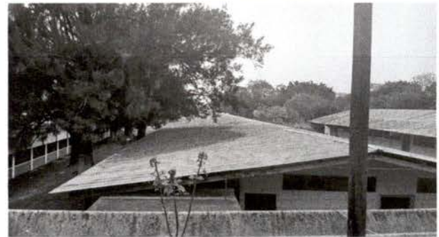
Instalación de Lámina troquelada Aluzinc calibre 26 para aulas de 6to. Perito Contador
