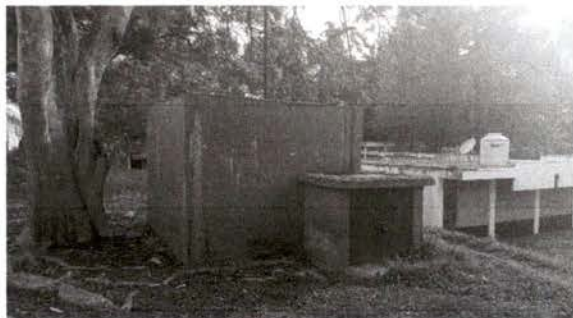
Limpieza y pintura de cisterna
