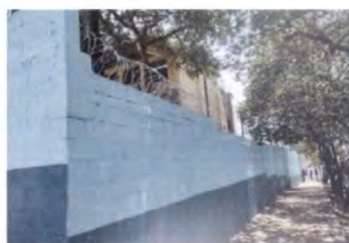
FOTO 8: Levantamiento de muro perimetral ya existente de block con tubo gh, malla galvanizada, soleras intermedias y columnas.
