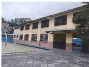
Foto 3: Sustitución de vidrios
