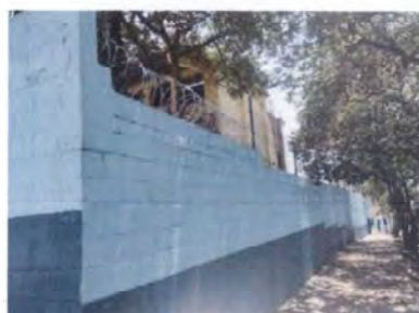
Foto 4: Pintura en muros exteriores (pintura de aceite)
