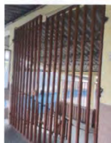
foto 6: Mantenimiento a barrandas (Chapa, lija, pintura, desmontaje, nivelar, incluye cambio de rejas que estan occidadas)
