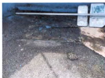
FOTO 7: Sustrucción tapadera de caja de recolección de agua
