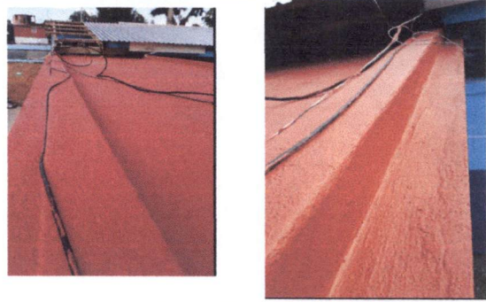
Foto 2: Impermeabilización de losa en pasillo principal
