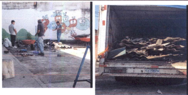
Foto 5: Limpieza de trabajos
