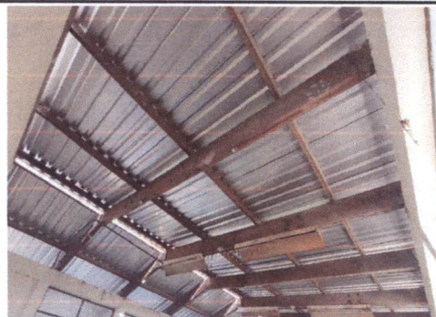
Foto 4: Mantenimiento de estructura de madera
