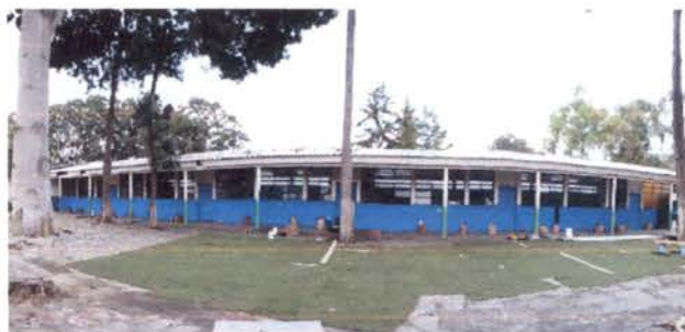
Foto 6: Pintura en corredor
