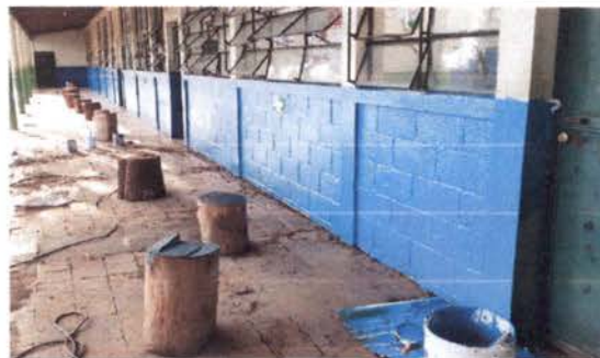
Foto 4: Pintura en corredor
