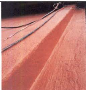
Foto1: Losa de pasillo principal
