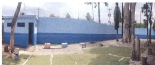
Foto 2: Pintura en muros exteriores
