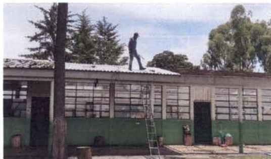
Foto 2: Instalación de lámina de aluzinc en aula de segundo primaria
