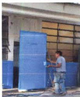
Foto 5: Reparación y pintura de puertas
