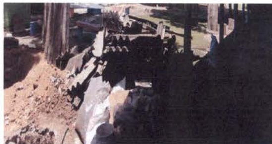
Foto 2: Cambio de láminas en mal estado
