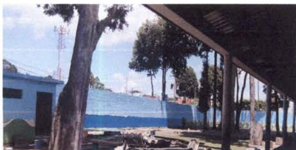
Foto 1: Pintura en muros exteriores
