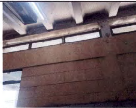
Foto 8: Paredes sanitarios de niños
