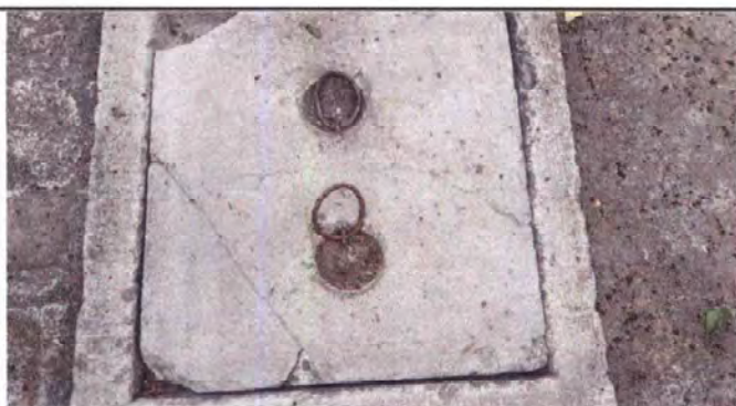
Foto 3: Tapadera de cisterna de agua que filtra el polvo y basura. Se colocará una de metal.
