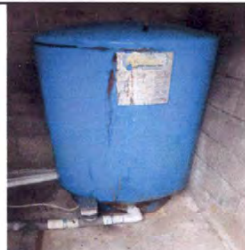
Foto 2: Tanque de 85 galones con perforaciones que ha sido reparado continuamente y está a punto de colapsar. Es un accesorio de la bomba de agua.
