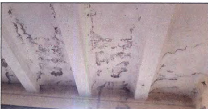
Foto 5: Losa de aulas la cual presenta deterioro en la pintura.
