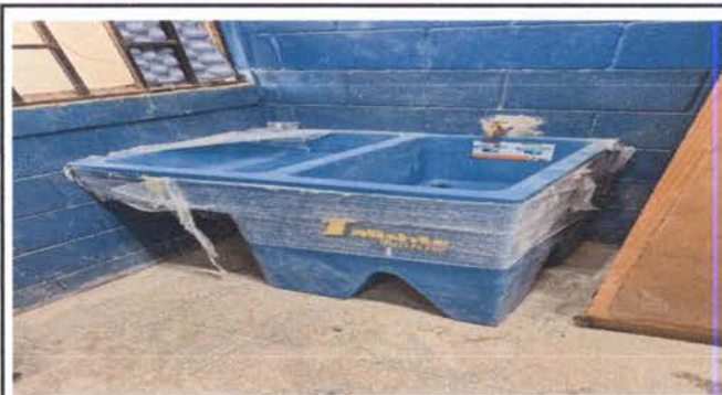
Foto 6: instalacion de la pila
