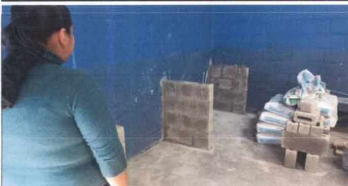
Foto 5: instalacion y suministro de encimera de cocina
