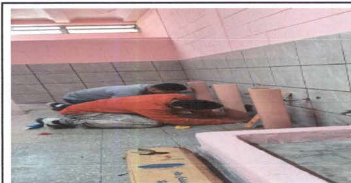
Foto 5: instalacion de lavamanos
