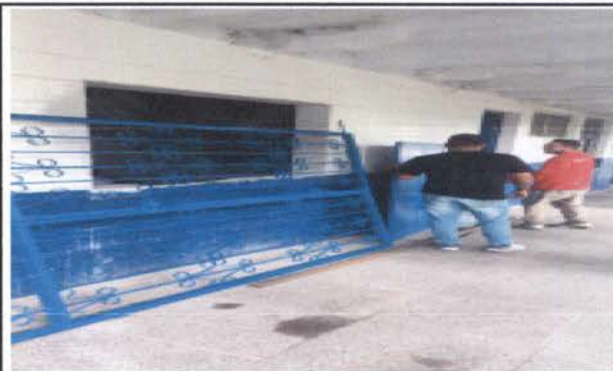
avances en la colocacion de la puerta de reja
