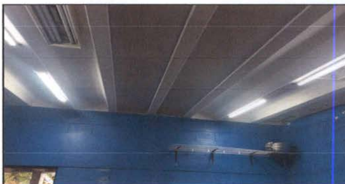
Foto 4: instalacion de lamparas Tipo Led en cocina
