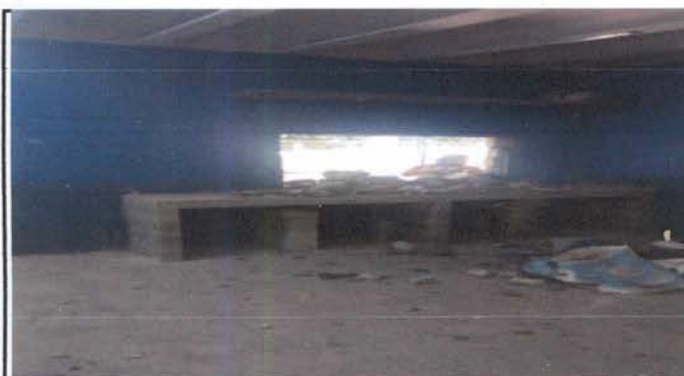
Foto 3: instalacion de la instalacion de ventana
