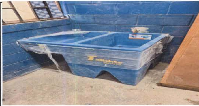
Foto 3: instalacion de pila en area de cocina
