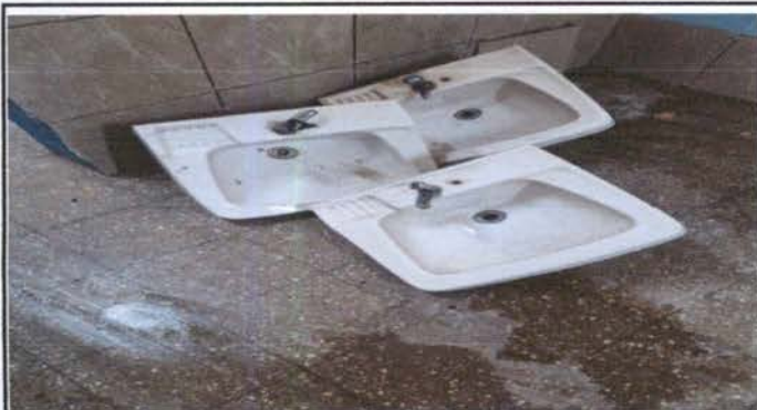
Foto1: demolicion de 5 lavamanos
