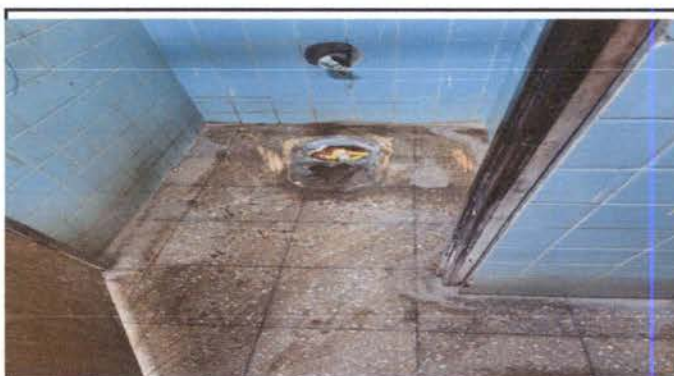
Foto 4: resane antes de la instalacion de sanitarios
