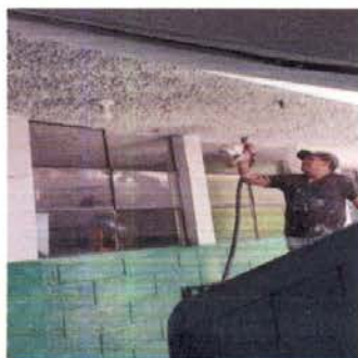
Pintando con soplete el techo del primer nivel.
