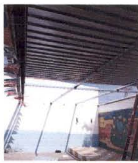
Montaje de estructura de láminas y tubos galvanizados, el techo de patio.
