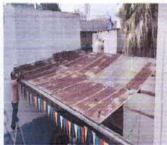
Desmontaje de estructura del techo del patio.
