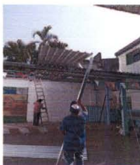
Montaje de estructura de láminas y tubos galvanizados, el techo de patio.
