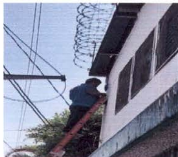
colocando tubo para aguas pluviales
