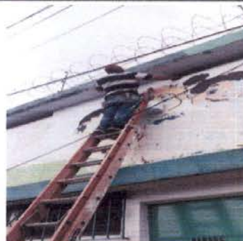
Despintando el exterior del edificio.
