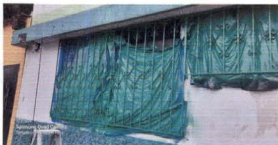
Pintando balcones del lado fuera
