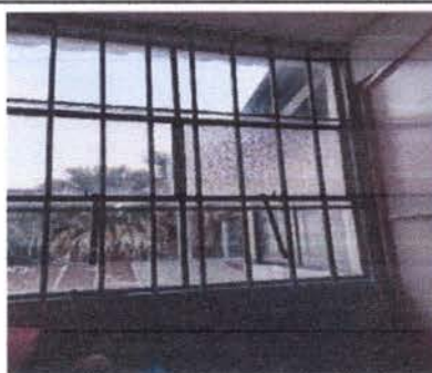
Sustitución de estructura de metal fijo, por estructura corrediza más vidrios.
