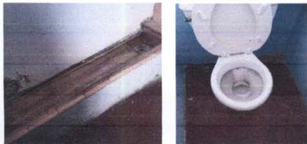
Mantenimiento de mingitorio y baños con ácido muriático.
