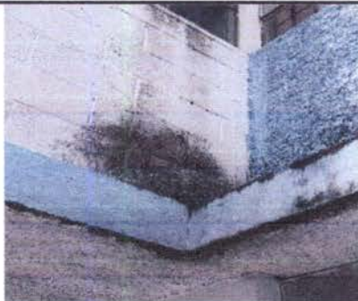
Pintura de aulas, pasillos, bodega, dirección, patio interiores
