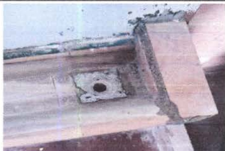
sustitución de reposadera en mingitorio de varones.
