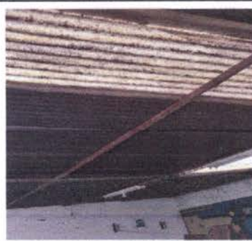
Sustitución de lámina para lámina troquelada 5 mt por 10 mt. En patio de 1er. Nivel
