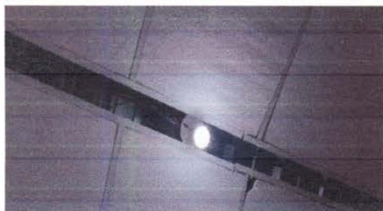
Sustitución de lamparas LED 2 x 40 en 8 aulas, bodega, patio
