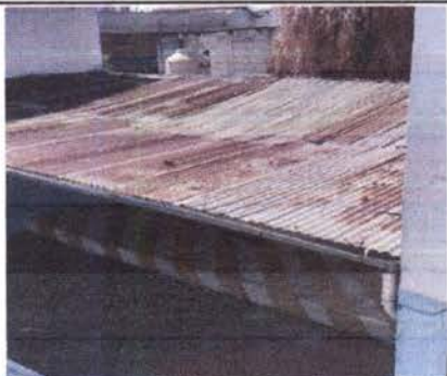
Sustitución de lámina por lámina troquelada calibre 26, en techo del patio, 1er. Nivel
