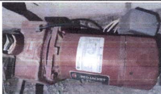
Sustitución de bomba de agua de 1/2 HP
