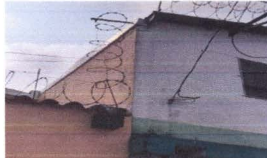
Sustitución de canal de metal del 2do. Nivel largo 17 ML. Reparación de 2 bajadas de agua de 6 ML c/u, del 2do nivel lado norte.
