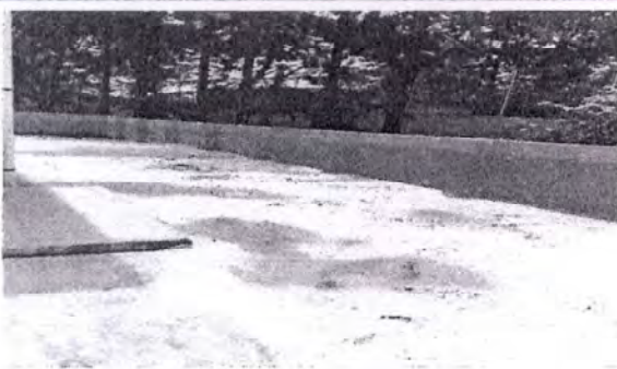
Foto 9: Fundición de torta de concreto de 8 cms de espesor con electro malla 9/9 de 105 mts cuadrados.
