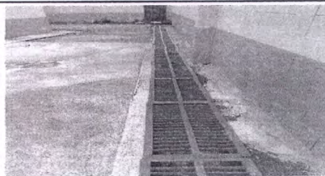
Foto 10: Fabricación e instalación de 23 mts lineales de rejilla en área de drenajes
