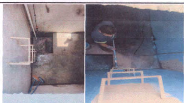
Foto 6: Remozamiento en área de cisterna de concreto, sellando de grietas, cambio de accesorios internos y pintura para piscinas antihongo y antiálga
