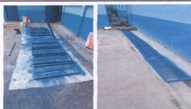
Foto 10: Fabricación e instalación de 23 mts lineales de rejilla en área de drenajes
