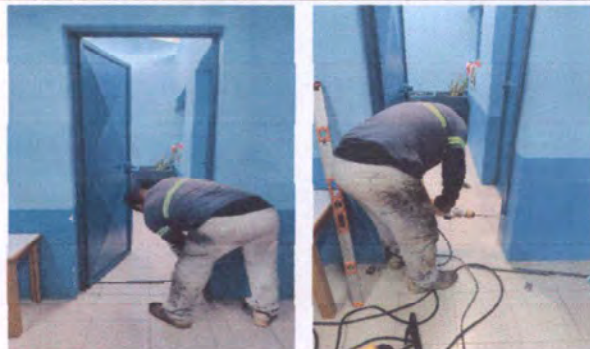
Foto 2: Fabricación e instalación de puerta para área administrativa de 2.17 mts por 80 cms
