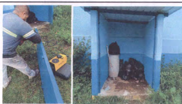
Foto 4: Fabricación e instalación de puerta para basurero con portacandados y pasadores de 1.90 mts por 1.66 mts.
