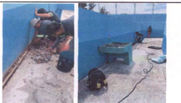
Foto 5: Instalación de pila de un lavadero con su respectivo drenaje de aguas negras
