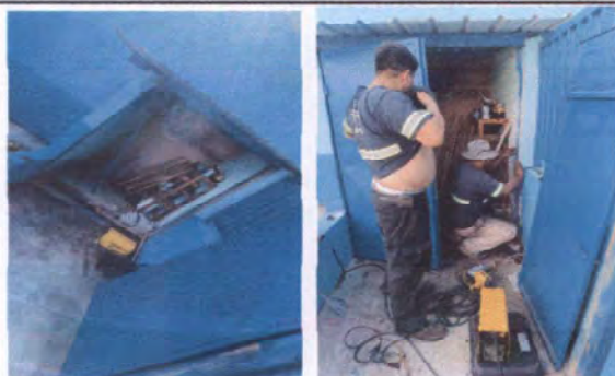
Foto 11: Fabricación e instalación de dos puertas de 0.75 cms de ancho por 1.60 mts de alto para área de bodega de huerto
