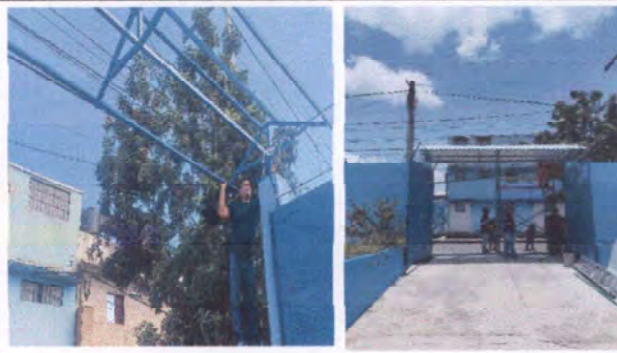
Foto 8: Fabricación e instalación de visera a dos aguas de 5.30 por 3 mts.
