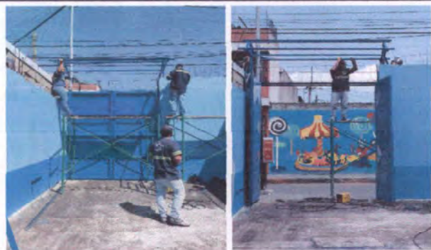
Foto7: Fabricación e instalación de visera a dos aguas de 3 mts por 3 mts
