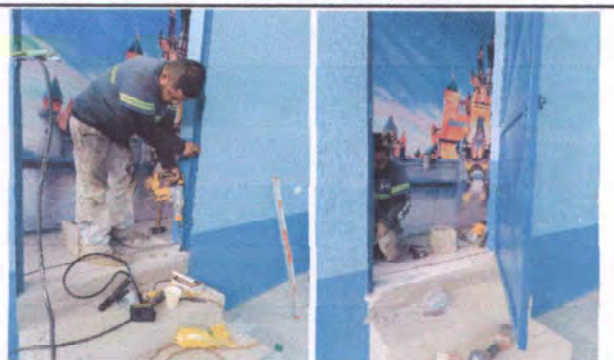
Foto 3: Fabricación e instalación de puerta para área de escenario 2.06 mts por 99 cms
