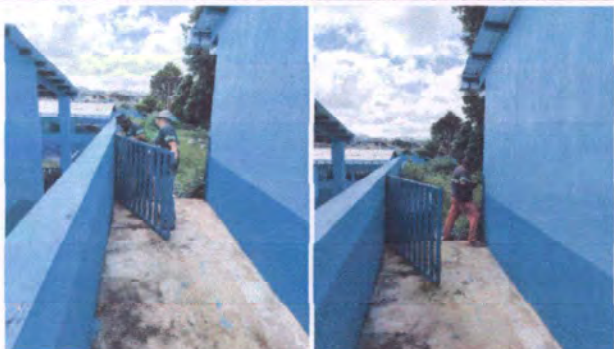
Foto1: Fabricación e instalación de reja en área de patio de 1.57 mts por 1.20 mts.
