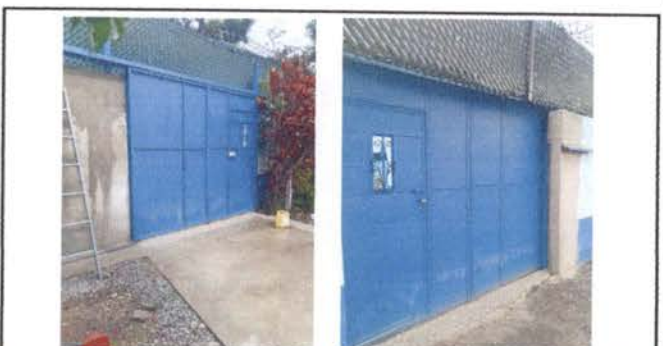
Foto 6: 4.5 Sustitución de portón de metal
