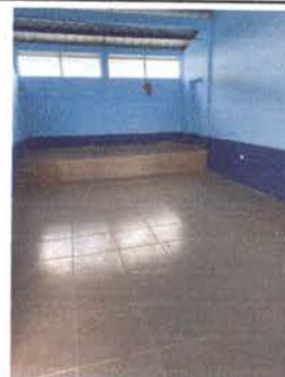
Foto 8: 6.7 Sustitución de piso de granito por cerámico
