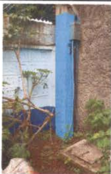
Foto 7: 19.14 Instalación de acometida eléctrica
