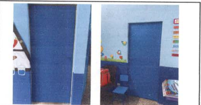
Foto 5: 4.3 Sustitución de puerta de metal
