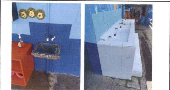
Foto 3: 10.9 Sustitución de grifos de estación de lavamanos
