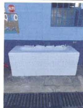
Foto 10: 10.5 Sustitución de lavamanos por estación de lavamanos
