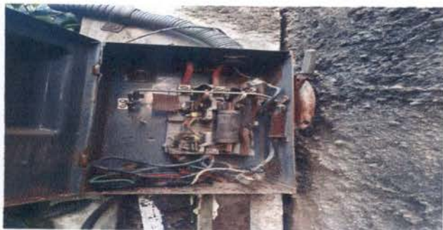
Foto 7: 19.14 Instalación de acometida eléctrica
