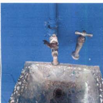
Foto 3: 10.9 Sustitución de grifos de estación de lavamanos
