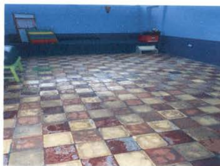
Foto 8: 6.7 Sustitución de piso de granito por cerámico
