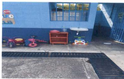
Foto 10: 10.5 Sustitución de lavamanos por estación de lavamanos
