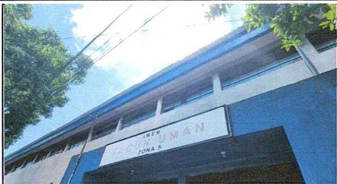
Foto 1: Lijado remozado y pintado de cenefa exterior.
