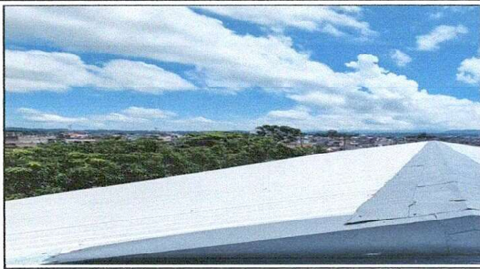
Foto 2: Sustitución de laminas y remozamiento de capote
