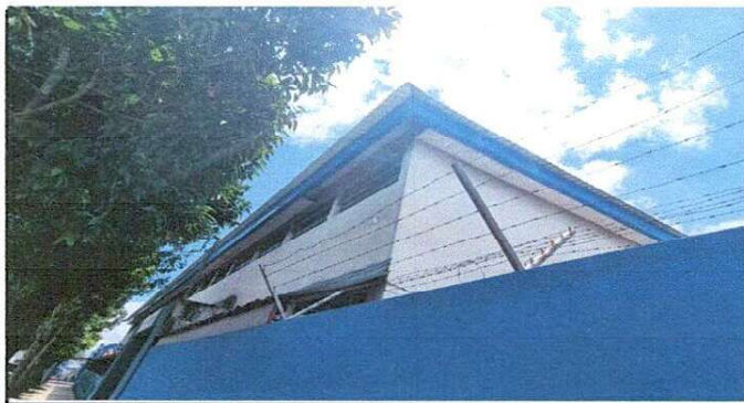
Foto 6: Lijado remozado y pintado de cenefa exterior.
