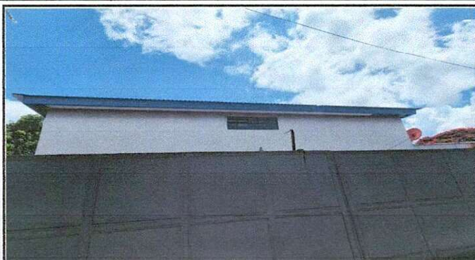
Foto 2: Lijado remozado y pintado de cenefa exterior.
