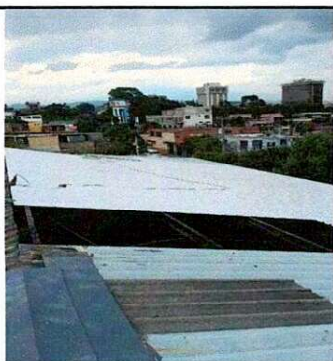
Foto 5: Colocación de laminas nuevas.
