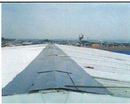
Foto 6: Sustitución de todas las laminas.
