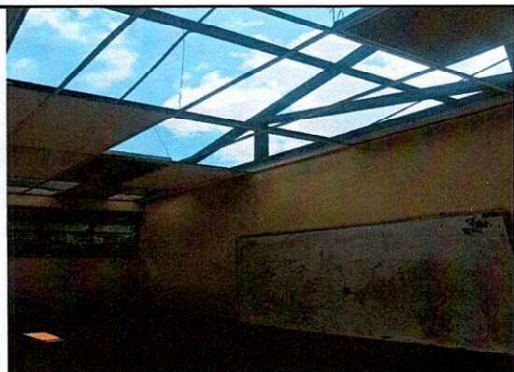
Foto 3: Desmontaje de laminas.
