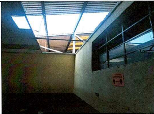
Foto 2: Desmontaje de laminas.
