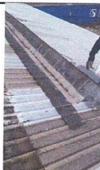
Foto 6: Levantado, remozado y pintado de capote parte interna.
