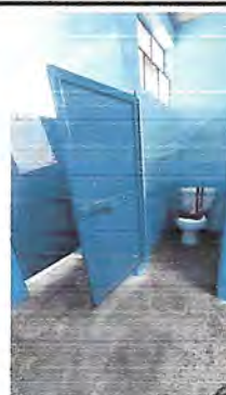
PUERTA DE BAÑO DE MUJERS REINSTALADA
