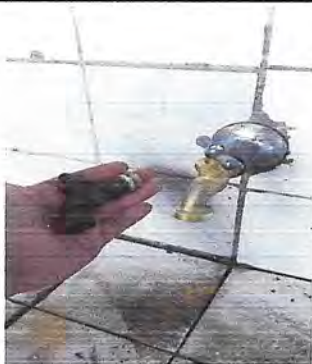
CAMBIO DE CHORROS EN LAVAMANOS DE HOMBRES
