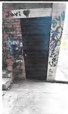
PUERTA DE BODEGA DE AREAS OCUPACIONALES REINSTALADAS
