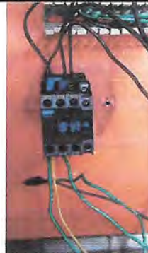
REEMPLAZO DE SISTEMA ELECTRICO DEL PANEL DE CONTROL DE BOMBAS DE AGUA
