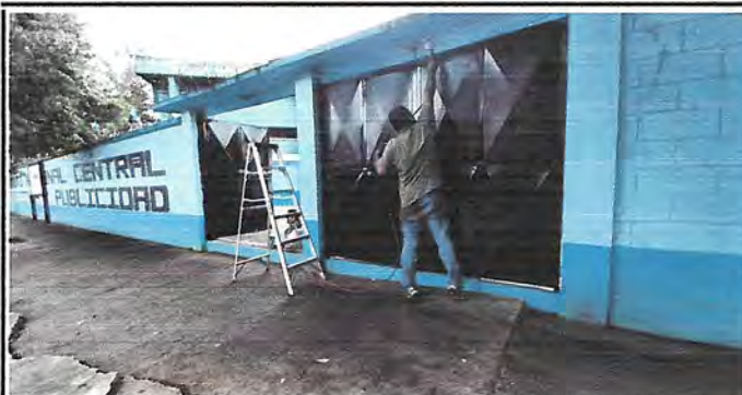
MANTENIMIENTO A PORTON 3
