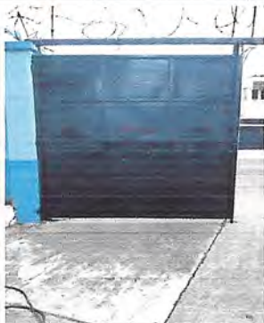
PORTON 2 REPARACION Y MANTENIMIENTO
