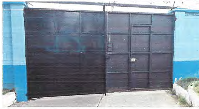
REPARACION DE PORTON 2 ANTES Y DESPUES
