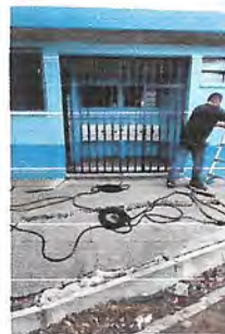
BARANDAS FABRICADAS Y EN SU INSTALACION BAÑO DE HOMBRES
