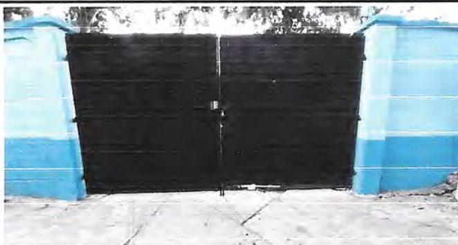
HOJA 1 YA REPARADA E INSTALADA
