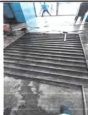
FABRICACION DE 2 BARANDAS
