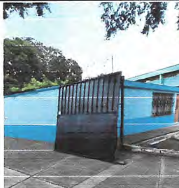
REPARACION DE HOJA 2 DEL PORTON1
