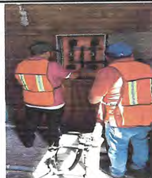
MANTENIMIENTO A PANEL DE CONTROL
