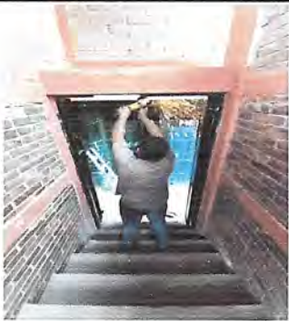
MANTENIMIENTO A PUERTAS DE GRADAS DE AREAS Y REINSTALACION
