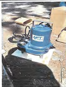
CAMBIO DE BOMBA SUMERGIBLE
