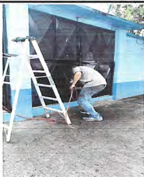
MANTENIMIENTO A PORTON 3
