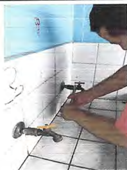
CAMBIO DE CHORROS DE LAVAMANOS DE HOMBRES
