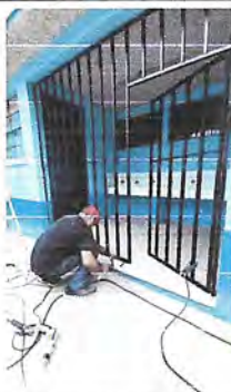
BARANDAS FABRICADAS Y EN SU INSTALACIÓN BAÑO DE NIÑAS
