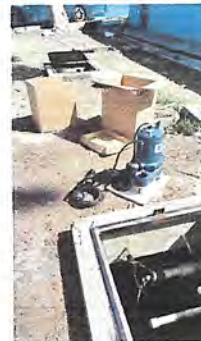
CAMBIO DE BOMBA SUMERGIBLE
