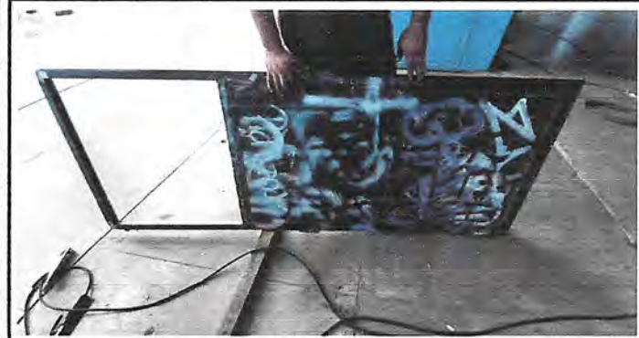
REPARACION DE PUERTA DE BODEGA DE AREAS
