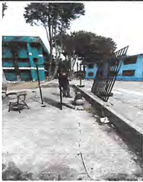
REPARACION Y PINTURA DE PUERTA DE AREAS Y PINTURA DE REJAS ELAVORADAS
