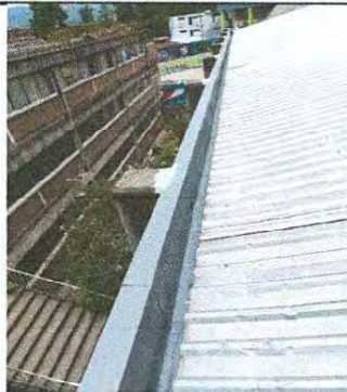
Foto 2: canal pintado y remozado
