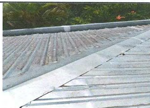
Foto 4: canal reparado y remozado
