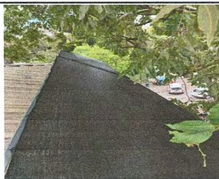
Foto 2: bases de saran instaladas
