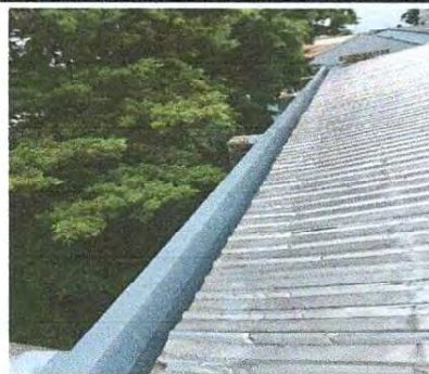
Foto 4: canal remozado y pintado
