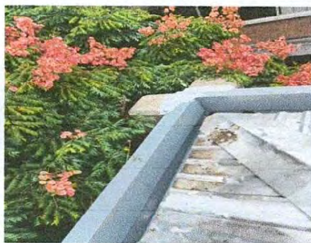
Foto 3: canal pintado y remozado
