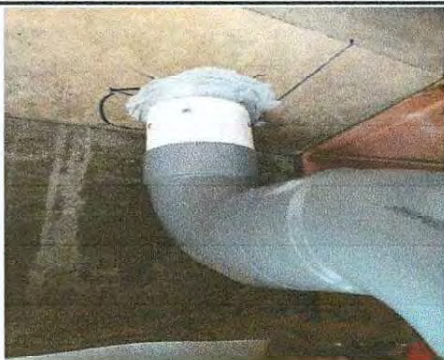
Foto 3: nuevos codos de bajadas de agua edificio talleres
