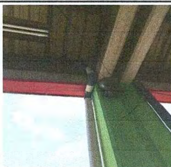
Foto 5: nuevas bajadas de agua
