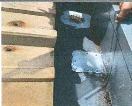
Foto 1: Bajadas de aguas nuevas y sellado de bajadas antiguas
