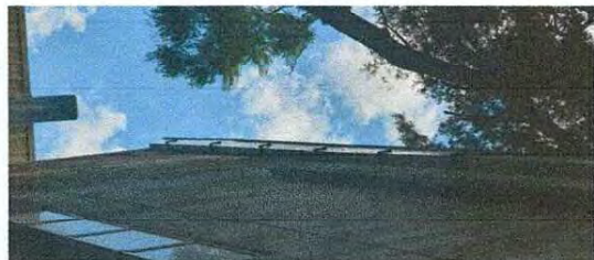
Foto1: Canal colocado con pescante nuevo.
