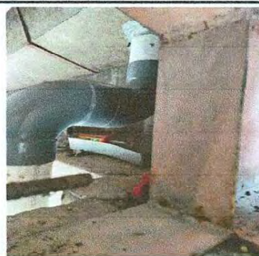
Foto 4: codos bajadas de agua de edificio de talleres
