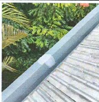
Foto 5: canal pintado y remozado
