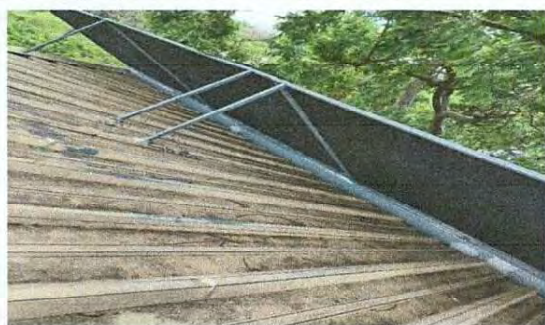
Foto 5: bases de saran instaladas
