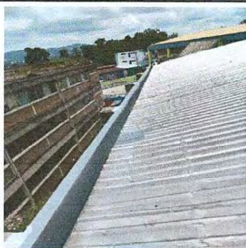
Foto 1: canal pintado y remozado
