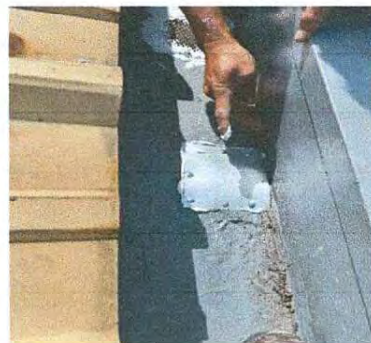
Foto 2: sellado de bajada de agua viejas
