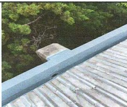
Foto 3: agujeros de bajadas de agua arreglado y remozado
