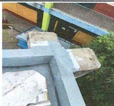
Foto 5: reparación de uniones
