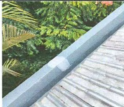
Foto 2: canal pintado y remozado
