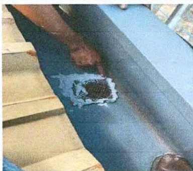
Foto 5: sellando bajada de agua viejas y tapadas
