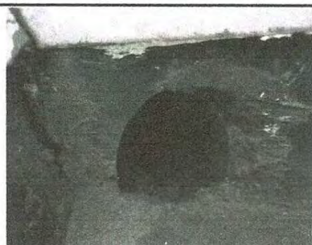
Foto 4: reparacion de agujero
