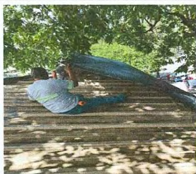
Foto 5: colocando base de saran en edificios
