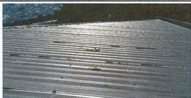
Foto 5: sellado de tornillos.
