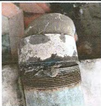
Foto 1: quitado codo viejos de bajadas de agua
