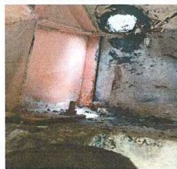
Foto 6: reparando agujeros de bajada de agua en canal de talleres
