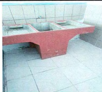
Foto 2: Sustitución de pila de cemento, por rajaduras en el depósito, quebrada de la parte posterior, salida del agua
