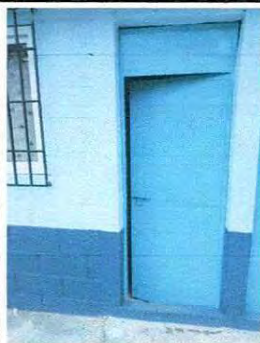
Foto 4: Sustrucción de puerta y marco de puerta de cocina, deteriorada del marco, oxidada y carcomida de la parte de abajo, topa en el piso al abrir o cerrar
