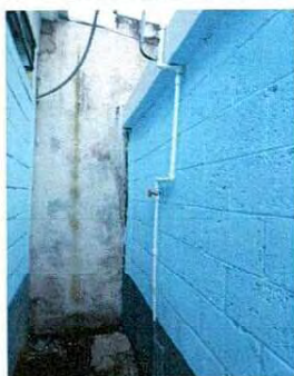
Foto 5: Pintura del interior y exterior de la cocina, deterioro de la pared por el salitre, saneamiento
