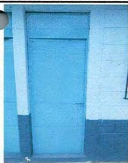
Foto 5: Sustrucción de puerta y marco de puerta de bodega, deteriorada del marco, oxidada y carcomida de la parte de abajo, topa en el piso al abrir o cerrar
