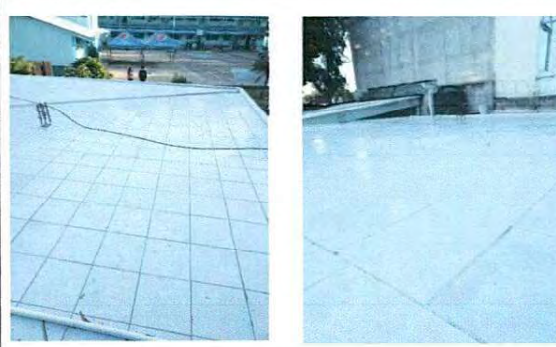
Foto 4: Saneamiento, raspado, impermeabilizar terraza de cocina, filtración de agua, sustituir caídas de agua
