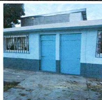
Foto 4: Sustrucción de puerta y marco de puerta de cocina, deteriorada del marco, oxidada y carcomida de la parte de abajo, topa en el piso al abrir o cerrar
