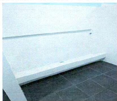
Foto 5: Sustitución de flauta, llave y contrallave, quitar bordillo, para dejar al ras de piso caída de orines
