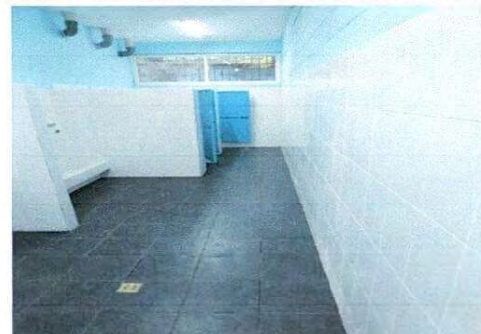
Foto 6: Sustitución de azulejo, mingitorios, servicio sanitario de varones
