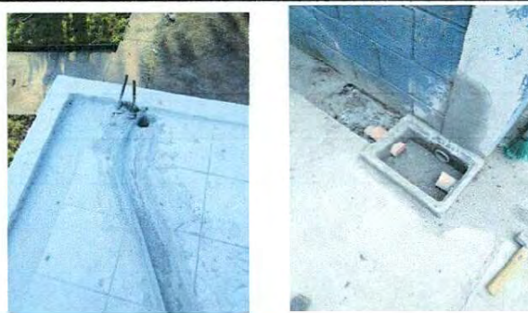
Foto 2: Mantenimiento caída de agua terraza de cocina, sustitución del tubo de caída
