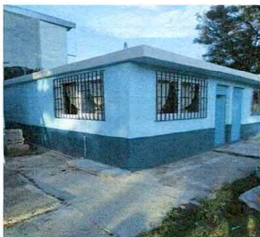
Foto 3: Sustrucción de ventana por daño del marco, vidrios no abren, colocación de balcón
