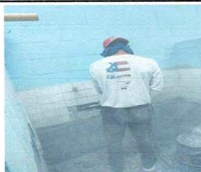
Foto 4: Sustrucción azulejo, lavamanos y accesorios por deterioro, filtración de agua hacia el piso
