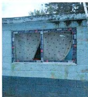
Foto 3: Sustitución de ventana por daño del marco, vidrios no abren, colocación de balcón
