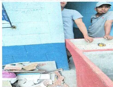
Foto 2: Sustitución de pila de cemento, por rajaduras en el depósito, quebrada de la parte posterior, salida del agua
