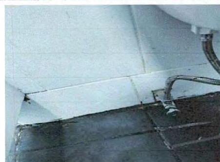
Foto 6: Acople de tubo de metal a tubo pvc, sustitución llave de paso de agua de servicios sanitarios de varones y niñas
