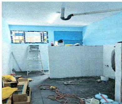
Foto 1: Sustitución de piso servicio sanitario varones, dañado por el orin, filtración del orinal, caída de agua, daño llave de agua de sanitarios
