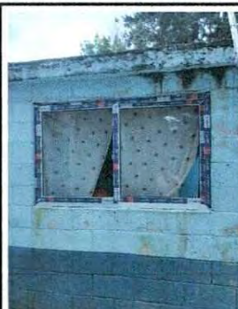
Foto 4: Sustitución de ventana, por deterioro del marco, las paletas de vidrio estan flojas, no se puede abrir, colocación de balcón
