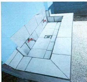
Foto 1: Sustrucción de azulejo, accesorios de lavamanos exterior del servicio sanitario de varones
