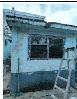
Foto 4: Sustitución de ventana, por deterioro del marco, las paletas de vidrio estan flojas, no se puede abrir, colocación de balcón
