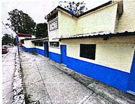
Foto 10: Aplicación de pintura en fachada.
