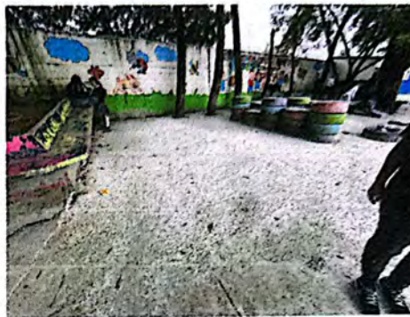
Foto 8: Cabe resaltar que el día de la fundición de la carpeta de concreto llovió, por lo que se vio comprometido el acabado.
