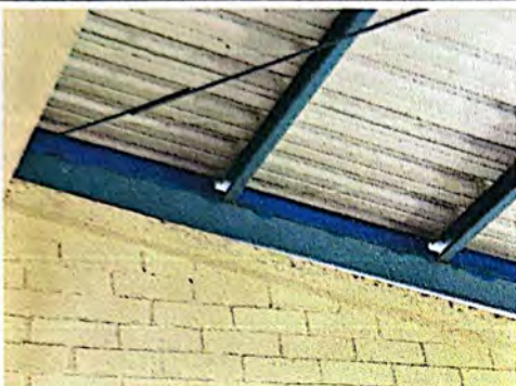
Foto 1: Estructura metálica portante para cierre en techo instalada.
