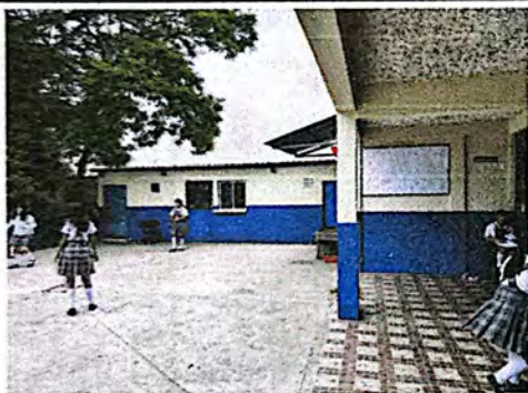
Foto 9: Edificio con aplicación de pintura.
