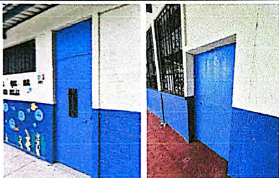
Foto 3: Mantenimiento de Puertas, incluye lijado y pintura.
