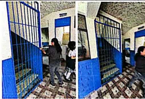
Foto 6: Puerta tipo reja, para protección en módulo de gradas.
