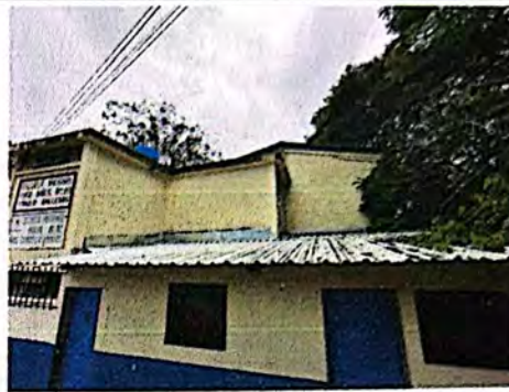
Foto 2: Flashing instalado, para corregir problemas de filtración.
