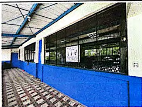
Foto 5: Suministro y aplicación de pintura
