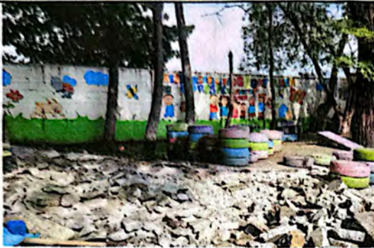
Foto 7: Proceso de demolición de Concreto existente.
