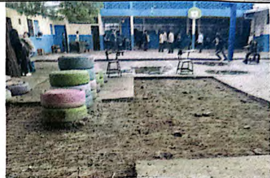
Foto 8: Preparación del área de fundición para la torta de cemento, con refuerzo de acero tipo electro malla.
