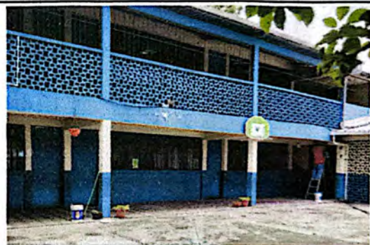
Foto 10: Aplicación de pintura exterior.
