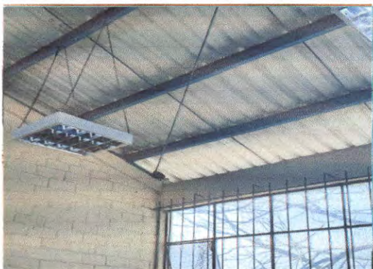
Foto 3: En la parte superior se colocaran ventanas tipo PVC para cerrar los 30 cms aproximadamente existentes
