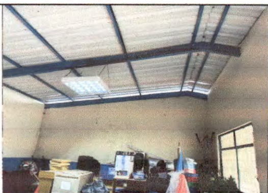
Foto 5: Es necesario colocar estructura metalica para sellar espacios
