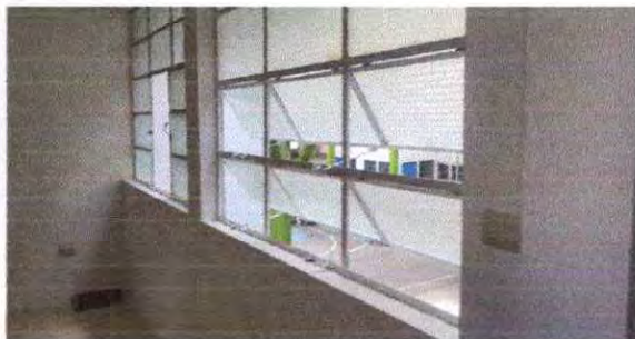
Foto 17: Ventas del segundo nivel estan selladas se modificarán para que entre ventilación.
