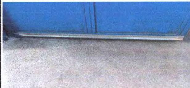
Foto 20: .Guarda polovos en las puertas para evitar que eantren roedores en los salón de clases y eb cocina
