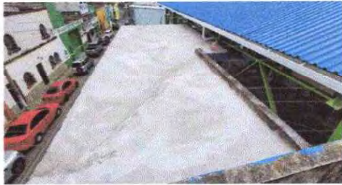
Foto 1: Finalización de los trabajos de Remoción de mezcón existente, limpieza y elaboración de pañuelos de mezcón nuevos, impermeabilización de área
