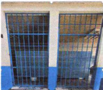
Foto 13: Instalación de rejas en sanitarios
