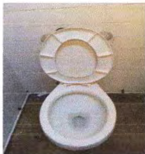
Foto 15: Instalación de inodoros en la jornada vespertina
