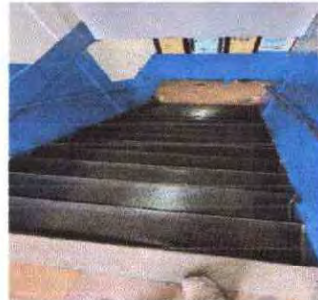
Foto 16 : Sustitucion de alfombra de trafico pesado existente de gradas de escuela
