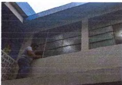
Foto 17: Modificando las ventanas del segundo nivel
