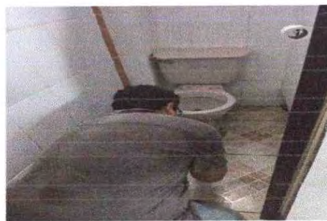
Foto se esta desistallando el inodoro en el primer nivel de maestros j. m
