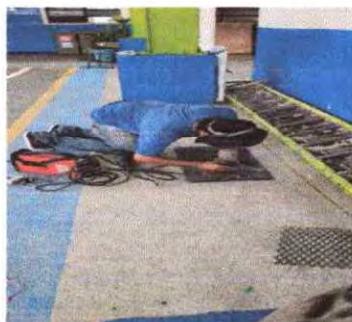
Foto 14: Acondicionamiento de reposaderas de escuela se les colocará malla para evitar que los niños depositen basura y que los ratones sigan saliendo de las reposadera.
