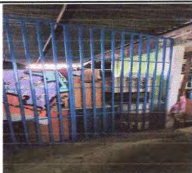
Foto 19: Instalación de reja en la bodega del segundo nivel para separar la cocina de la j.v con la bodega de la j.m
