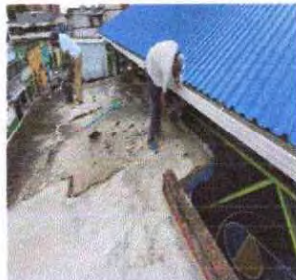
Foto1: Remoción de mezcón existente, limpieza y elaboración de pañuelos de mezcón nuevos, impermeabilización de área
