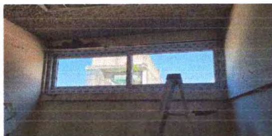
Foto 22. colocando la ventana de pvc
