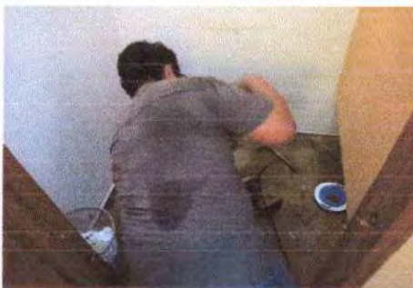
Foto 15: Instalación de inodoros en la jornada vespertina
