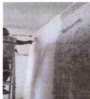
Foto 4:Sustitucion de repello de todas las paredes y cielo de la oficina de supervision
