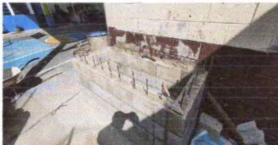
Foto 12: Fabricación de la pila.
