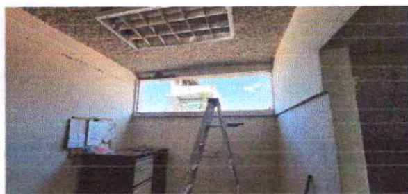
Foto 21 colocación de la venta de pvc.
