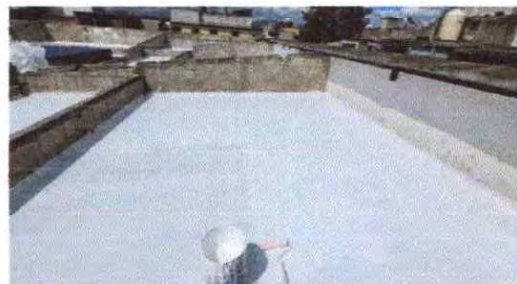
Foto 6: Limpieza y aplicación de impermeabilizante a losa de aulas de escuela 338 metros cuadrados
