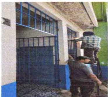
Foto 13: Instalación de rejas en sanitarios
