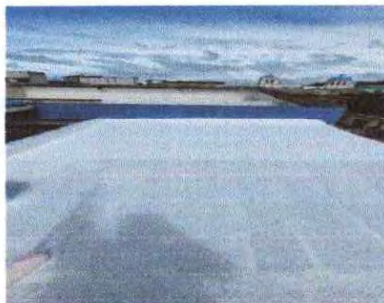
Foto 2, impermeabilización de área
