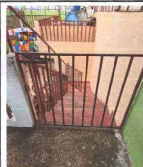
Foto 9: Sustitución de barandas de metal en gradas de segundo y tercer nivel
