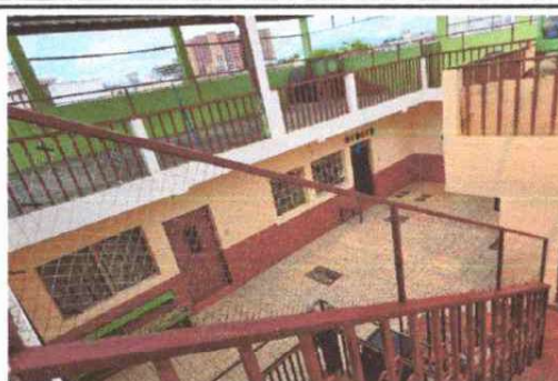
Foto 8: Colocación de baranda de metal en orilla de patio del tercer nivel
