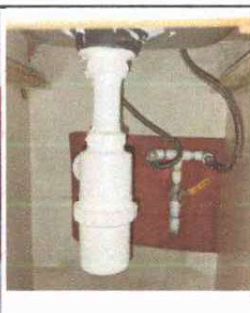
Foto 5: Reparación de cocina, sustitución de tubería, sustitución de mezcladora y reparación de mueble del lavatrastos
