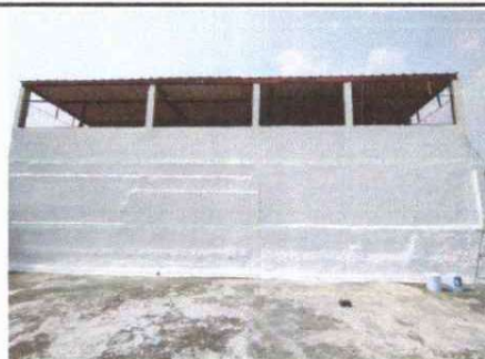
Foto 12: Impermeabilización de muro exterior para evitar la filtración de agua
