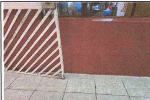
Foto 2: Pintura en muros interiores con pintura de agua en paredes y cielo, pintura de aceite en zócalo
