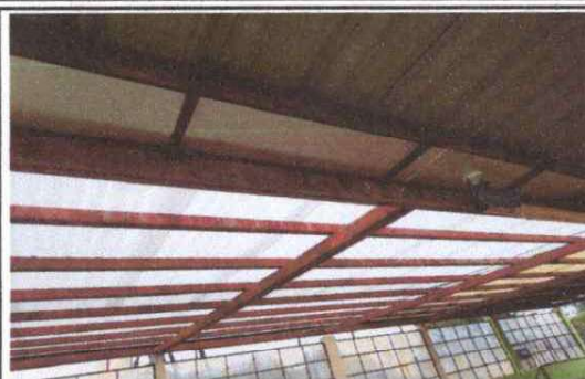
Foto 7: Sustitución de canal de metal y reparación de bajada de agua pluvial
