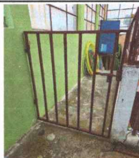
Foto 9: Sustitución de barandas de metal en gradas de segundo y tercer nivel
