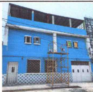
Foto 11: Reparación de frente, cernido, aplicación de sica Zero salitre y monotop. Pintura de exterior con pintura de revestimiento acrílico
