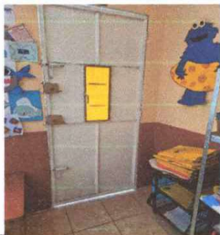
Foto 3: Mantenimiento a puerta de ingreso (lijado, cepillado, cambio de tubo inferior y aplicación de pintura anticorrosiva) y sustitución de chapas
