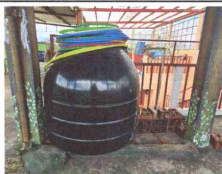
Foto 10: Mantenimiento y limpieza a depósitos de agua, sustitución de tubería y llave.
