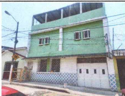
Foto 11: Reparación de frente, cernido, aplicación de sica Zero salitre y monotop. Pintura de exterior con pintura de revestimiento acrílico
