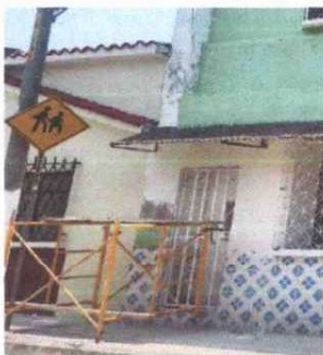
Foto 3: Mantenimiento a puerta de ingreso (lijado, cepillado, cambio de tubo inferior y aplicación de pintura anticorrosiva) y sustitución de chapas
