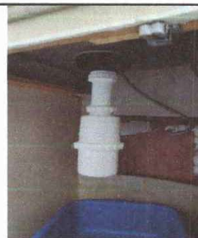
Foto 6: Sustitución de accesorios de inodoro y lavamanos
