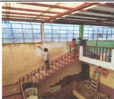
Foto 7: Pintura y remozamiento general del establecimiento educativo
