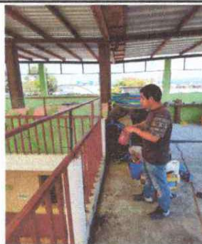
Foto 8: Colocación de baranda de metal en orilla de patio del tercer nivel
