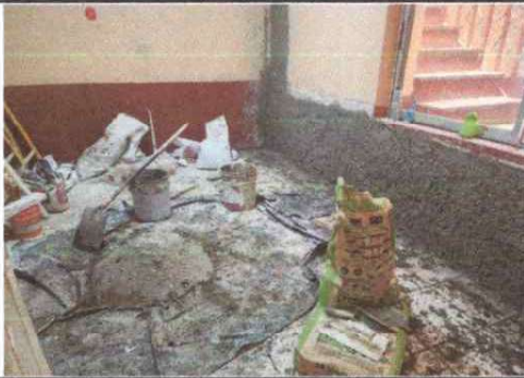
Foto 1: Reparación de paredes con cernido, repello aplicación de sica zero salitre y sica latex monotop
