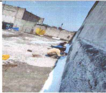
Foto 12: Impermeabilización de muro exterior para evitar la filtración de agua
