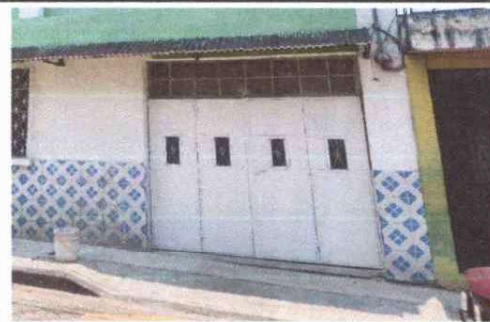
Foto 4: Mantenimiento a portón (lijado, cepillado, cambio de tubo inferior y aplicación de pintura anticorrosiva)
