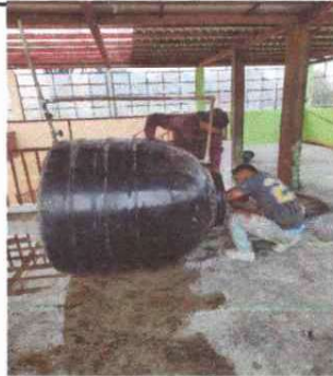
Foto 10: Mantenimiento y limpieza a depósitos de agua, sustitución de tubería y llave.
