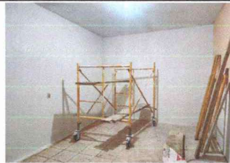
Foto 2: Pintura en muros interiores con pintura de agua en paredes y cielo, pintura de aceite en zócalo
