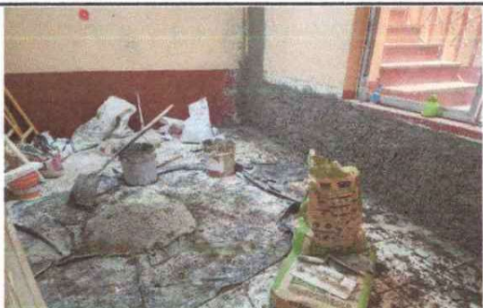
Foto 9: Cernido y repello de paredes
