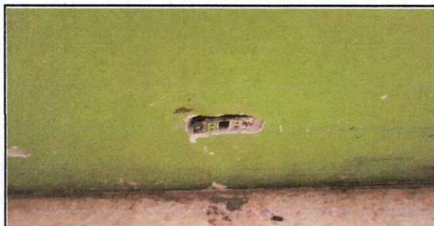
Foto 5: Suministro y cambio de toma corrientes de todo el establecimiento.
