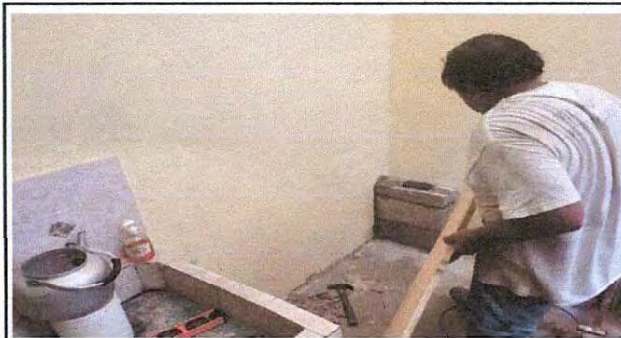
Foto 3: Construcción de Pileta para lavador de manos.
