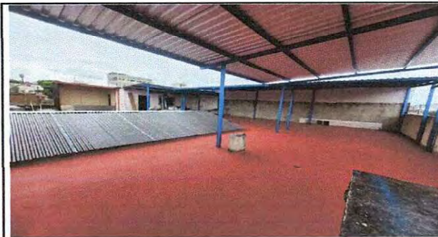
Foto 4: impermeabilizante en toda la terraza
