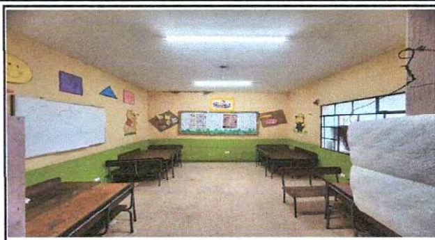
Foto 2: Suministro y cambio de sistema de iluminación de Aulas y corredores
