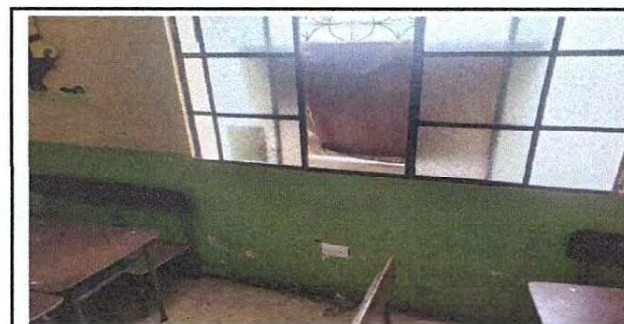
Foto 6: Suministro y cambio de toma corrientes de todo el establecimiento.
