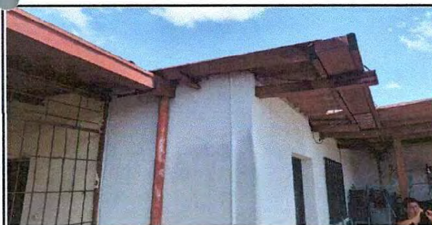
Foto 5: Cambio de laminas de Aula de planta alta
