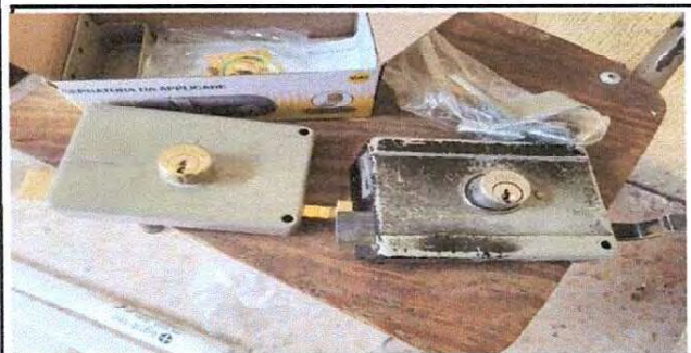
Foto 3: Cambio de Chapas de Puertas principales de metal del inmueble
