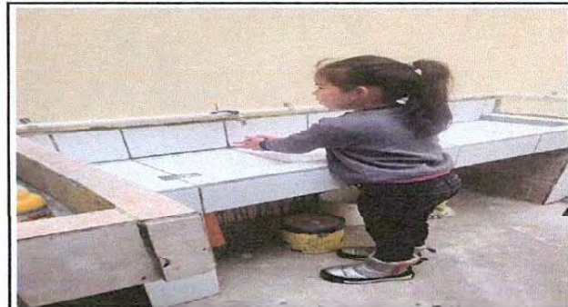
Foto 4: Construcción de Pileta para lavador de manos.
