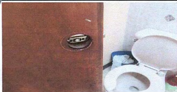
Foto 5: Cambio de Chapas de Sanitarios
