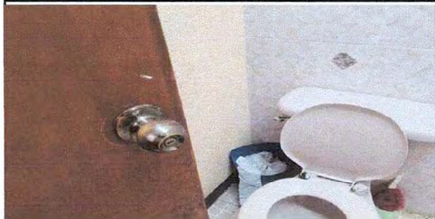
Foto 6: Cambio de Chapas de Sanitarios
