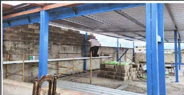
Foto 4: Construcción de Galera en area de Terraza
