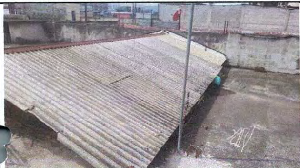
Foto1: Suministro y cambio de laminas
