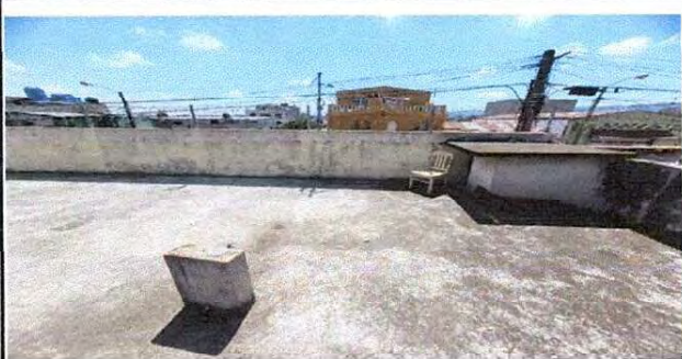
Foto 3: impermeabilizante en toda la terraza
