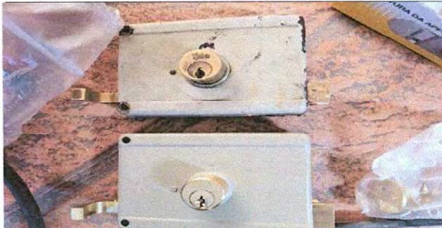
Foto 4: Cambio de Chapas de Puertas principales de metal del inmueble
