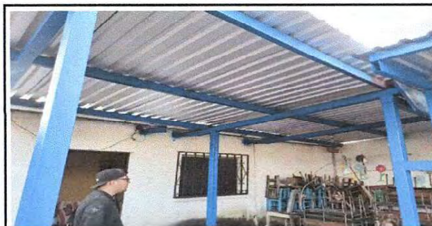
Foto 6: Cambio de laminas de Aula de planta alta
