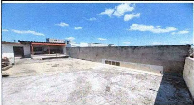
Foto 3: Construcción de Galera en area de Terraza
