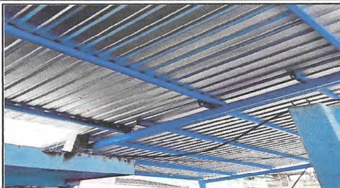
Foto 2: ESTRUCTURA METALICA TERMINADA DE REMOZAR Y PINTAR.
