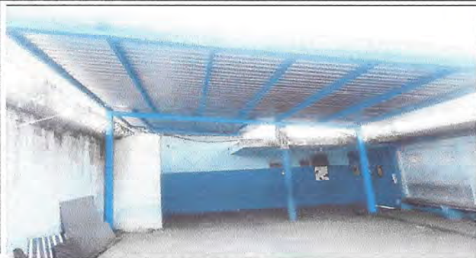
Foto 1: LAMINA TERMINADA DE COLOCAR.
