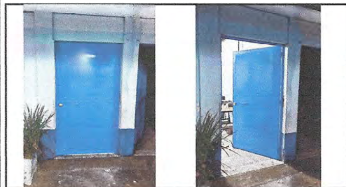
Foto 3: PUERTA DE COCINA NUEVA, COLOCADA Y PINTADA.
