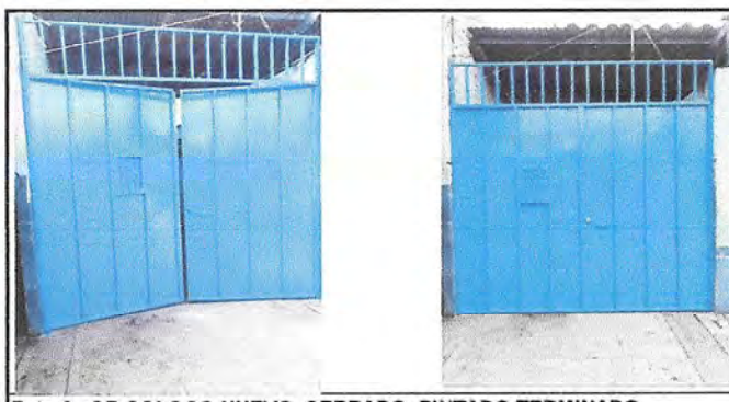
Foto 6: SE COLOCO NUEVO, CERRADO, PINTADO, TERMINADO.
