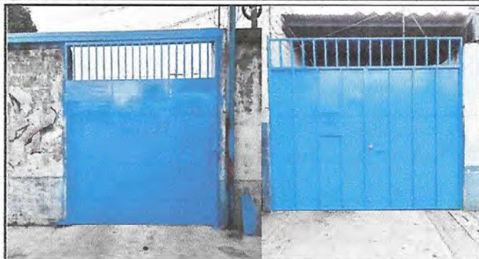
Foto 7: FINALIZADO PROCESO DE MANTENIMIENTO Y REMOZADOS DE LOS DOS PORTONES.
