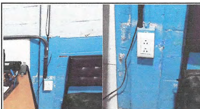
Foto 10: SE FINALIZA COLOCACION DE CONECTORES DOBLES EN DIRECCIONES Y CORREDORES Y AULAS.
