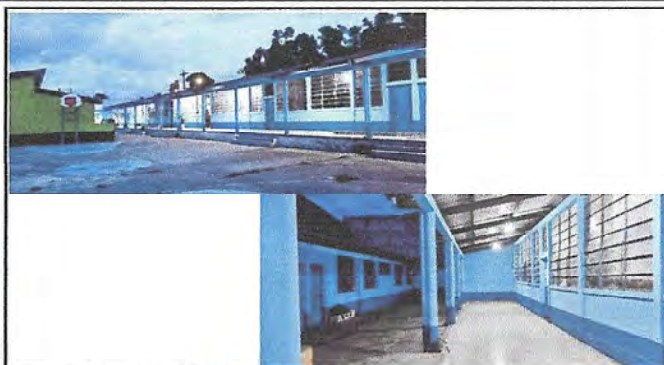
Foto 8: SE FINALIZA SISTEMA ELECTRICO COMPLETADO, BOMBILLAS, PLAFONERAS.
