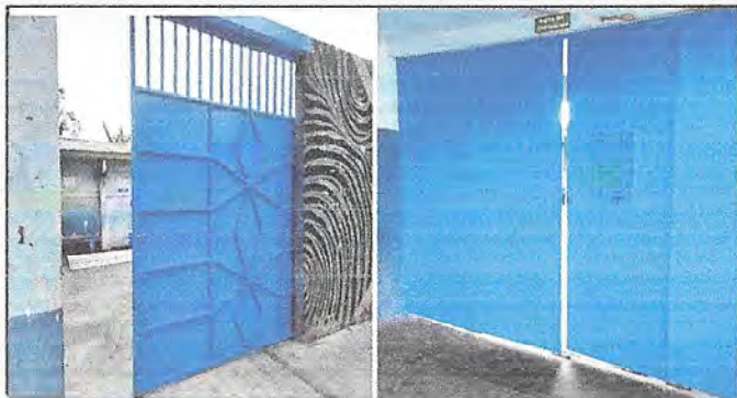
Foto7: SE HA HECHO EL PROCESO DE MANTENIMIENTO DE PORTONES, CAMBIO DE REIELES, CEPILLADO, LIJADO, PINTADO.
