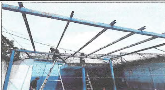
Foto 2: SEPILLANDO, LIJANDO, DESMONTANDO PARA TRATAMIENTO DE ESTRUCTURA METALICA.
