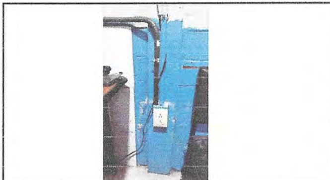
Foto 10: SUSTITUCION DE CONECTORES DOBLES EN AULAS Y CORREDORES, DIRECCIONES.
