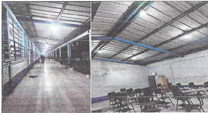
Foto 8: SE COLOCARON PLAFONERAS, BOMBILLAS AHORRADORAS EN CORREDORES Y SALONES DE CLASES, SE QUITARON LAS CANDELAS OBSOLETAS Y QUEMADAS.
