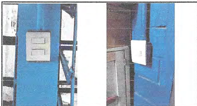
Foto 9: SE COLOCARON APAGADORES SIMPLES Y UN APAGADOR DOBLE, YA QUE LOS ANTERIORES ESTABAN QUEBRADOS Y OBSOLETOS.
