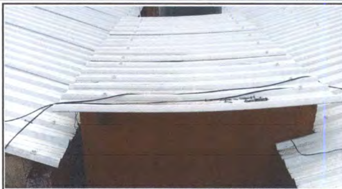
demolición de muro en terraza de 2do nivel para hacer trabajos por instalación y colocación de canal en ambas caídas de agua del enlaminado existente para desviar el agua y nuevamente levantar el muro con columnas e incluye cernido (es necesario ya que no hay suficiente espacio entre pared y lamina para hacer los trabajos y no hay
