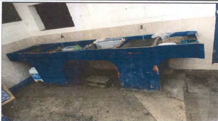
limpieza de drenaje en 2 pilas y cajas de registro por estar tapadas (posible desinstalación de pilas e instalación)
