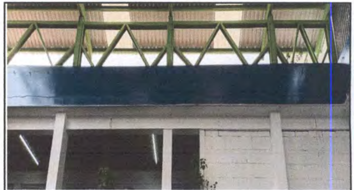
reparación de filtración en pared de la cancha deportiva en 2do nivel (picado, aplicación de cemento e impermeabilización )
