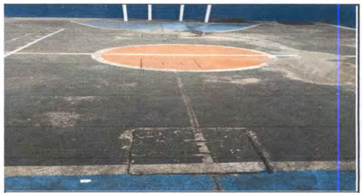
destapar cajas de registro y drenaje por tema de bloqueo y no se va el agua pluvial
