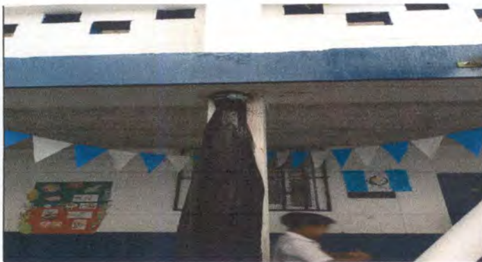
instalación de tuvo de pvc de 3" de 125 psi, codo y T para bajada de agua pluvial en cancha deportiva
