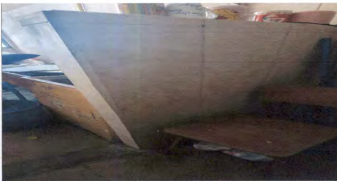
Demolición de muro en cocina del establecimiento (1.45 X 77)
