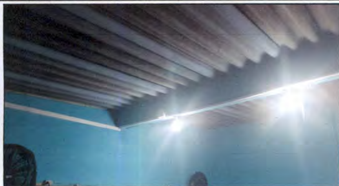
Sustitución de lámina por lámina troquelada aluzinc calibre 26 y estructura de soporte de metal en salones de 2do nivel
