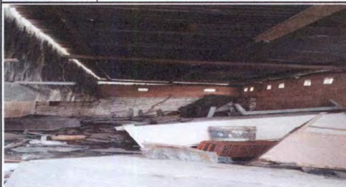
Cerramiento de espacio entre muro y techo, con block
