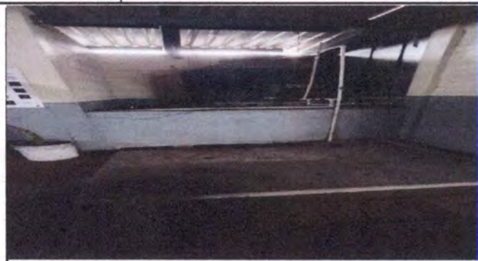
Cerramiento en area para bodega en segundo nivel
