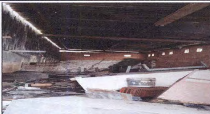
Desinstalar lamina y estructura actual y suministrar lamina de aluzin calibre 26 troquelada y estructura metalica nueva ( costanera acuachada)
