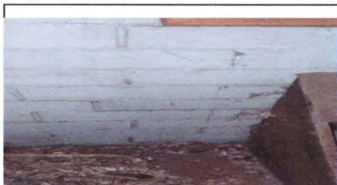
Pintar muros de biblioteca
