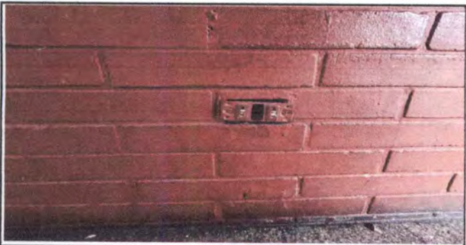
cambio de tomacorrientes dobles poralizados
