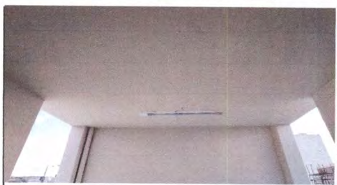
cambio de lampas de 2 listones Led en aulas # 2 referencia
