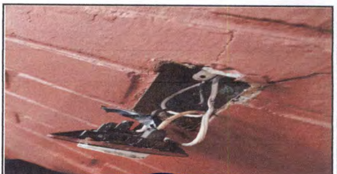
cambio de tomacorrientes dobles poralizados
