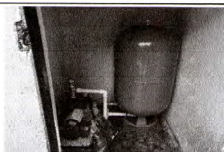
FOTO 10: SUMINISTRO DE BOMBA Y SISTEMA HIDRONEUMÁTICO, HACE FALTA COMPLETAR INSTALACIÓN.
