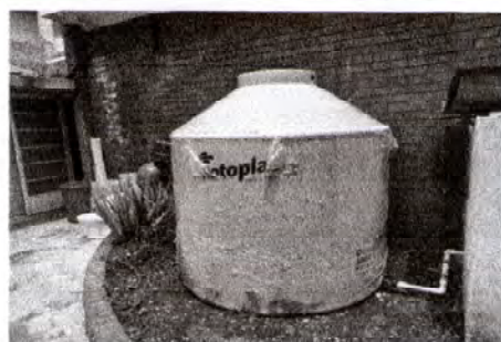
FOTO 8: SUMINISTRO E INSTALACIÓN DE DEPÓSITO DE AGUA ROTOPLAST DE 2,500 LTS. CON ACCESORIOS Y CONEXIÓN DE TUBERÍA DE AGUA POTABLE
